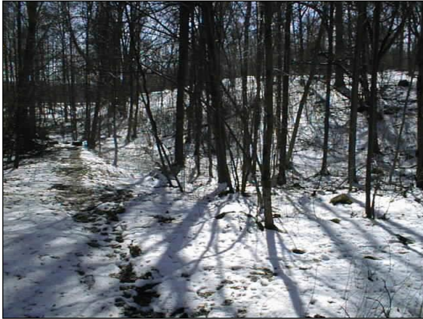
Bild 12. Befintlig dagvattenledning genom skogspartiet ner till Virserumssjön (den mittersta huvudledningen) i vänster del av bilden.
