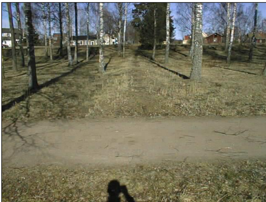
Bild 8. Dagvattenledningen från dagvattenområde Hu 12 sedd från utloppspunkten norrut.
