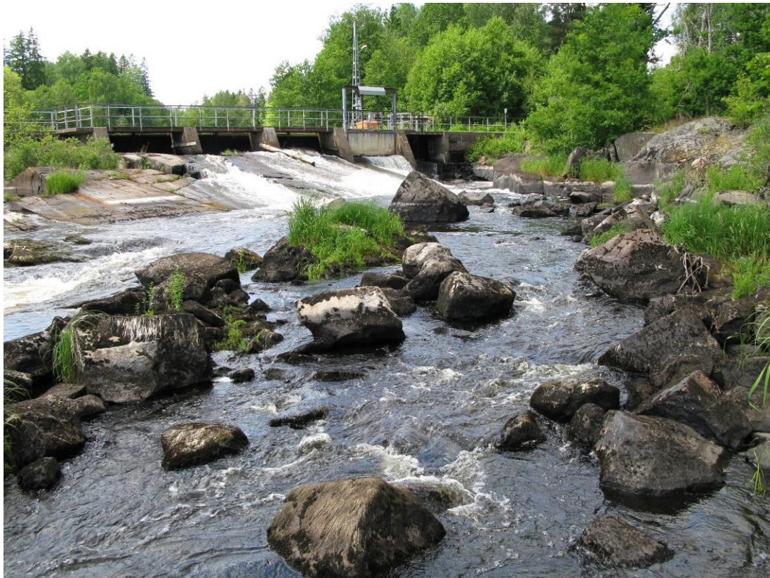
Figur 46. Vy över potentiellt lek område i torråran nedströms Finsjö övre kraftverk. Omlöpet mynnar till höger om utskovet längst till höger i bilden. Foto: T. Nydén.
