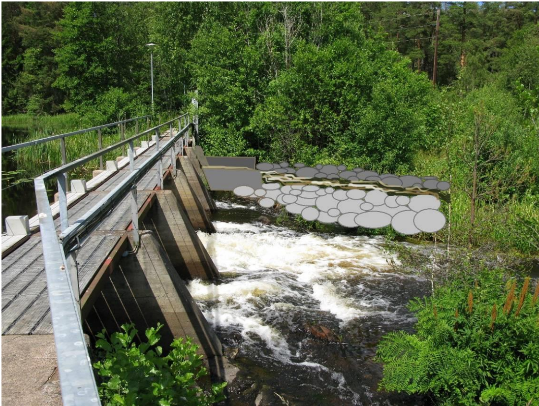
Figur 45. Retuscherat foto över Finsjö nedre reglering vid torråran, med skiss på ungefärlig placering och utseende på fiskväg. Foto: T. Nydén.
