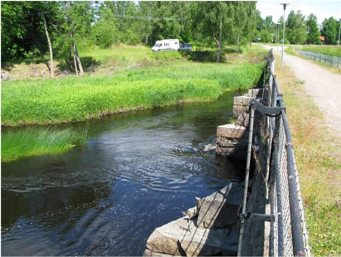
Figur 36. Den gamla valvbron i Fliseryd vid uppströmssidan, lokal 3 A – lämpligt ställe att skapa nya lekbottnar på. Foto: T. Nydén
