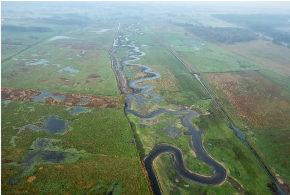
Figur 24. Klingavälsån i Skåne – ett rätat vattendrag som restaurerats genom återmeandring.
