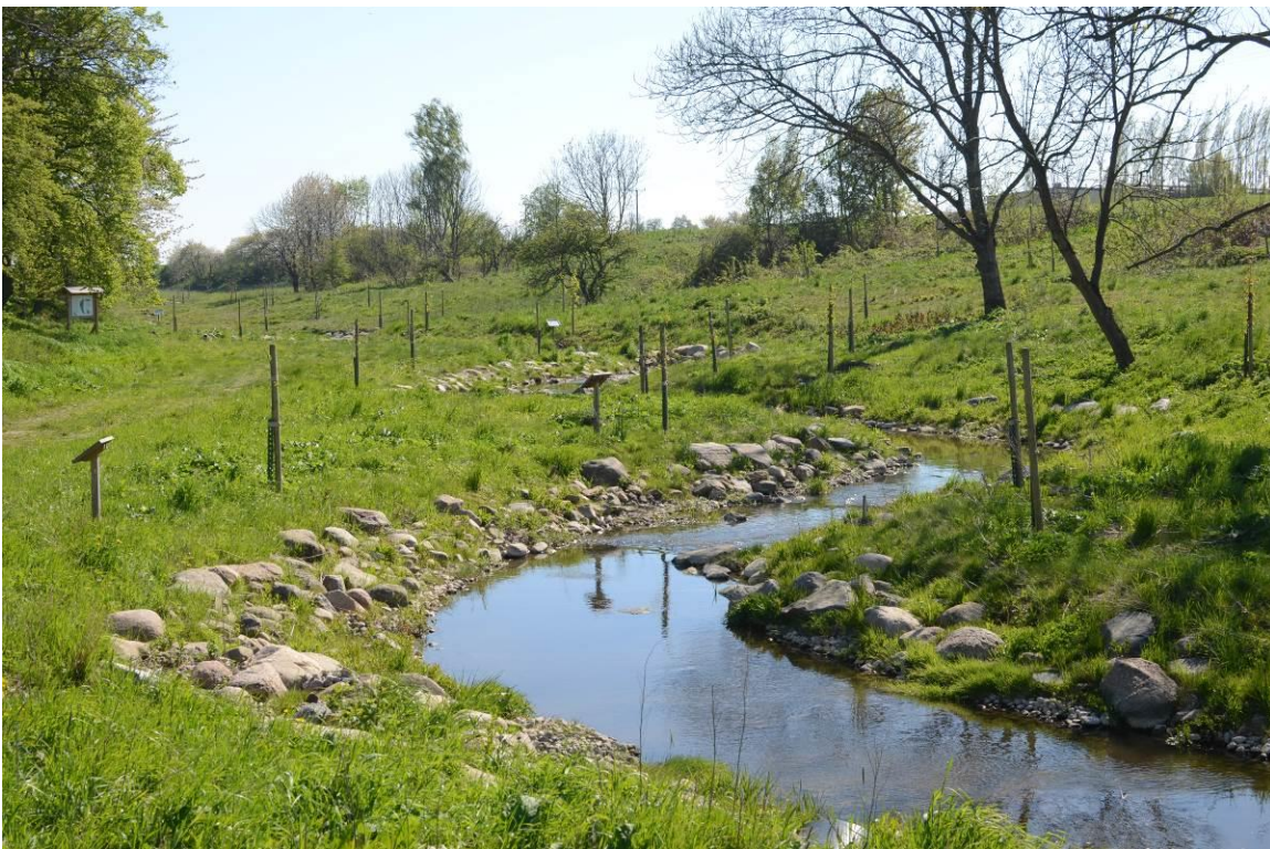
Figur 25. Tulltorpsån i Skåne, där flodplansrestaurering och återmeandring genomförts utmed långa sträckor.
