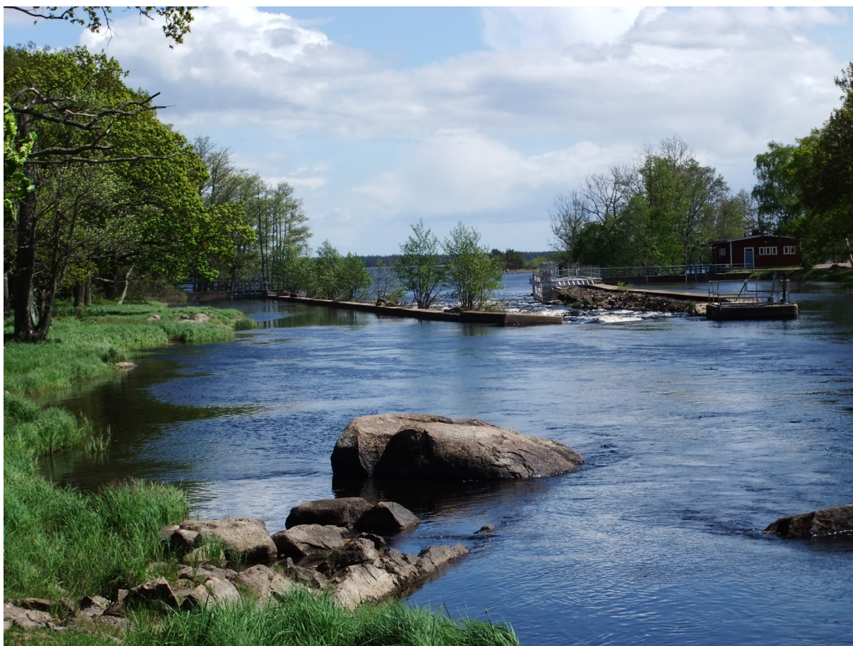
Figur 1. Dammbyggnationen vid Emåns utlopp i Östersjön vid Em. Notera öppningen i mitten och armarna i dammvallen, som styrde vattnet mot den vattenkraft som nyttjades där. Foto: Anders Kraft.
