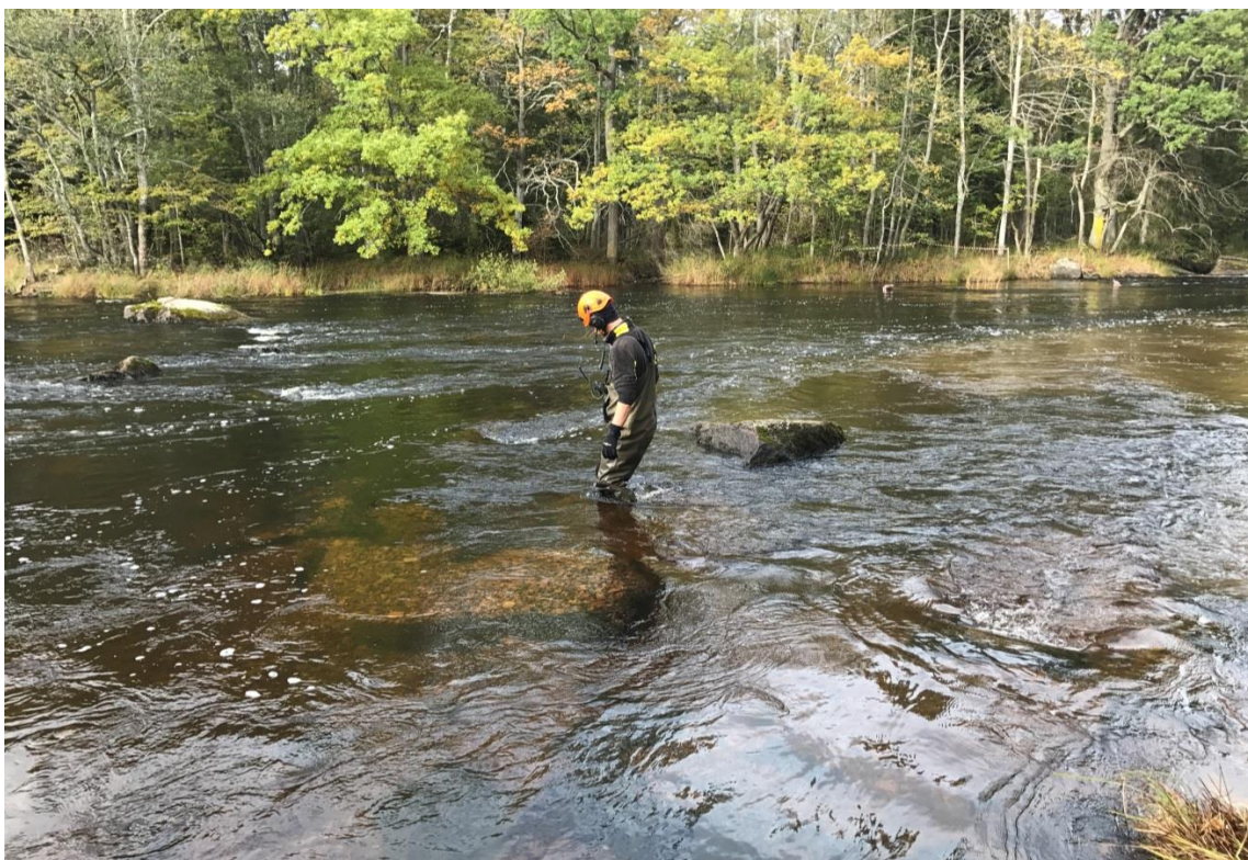
Figur 18. Utläggning av lekgrus på restaurerade strömnackar på Grönskogs gård. Foto: J. Nilsson.
