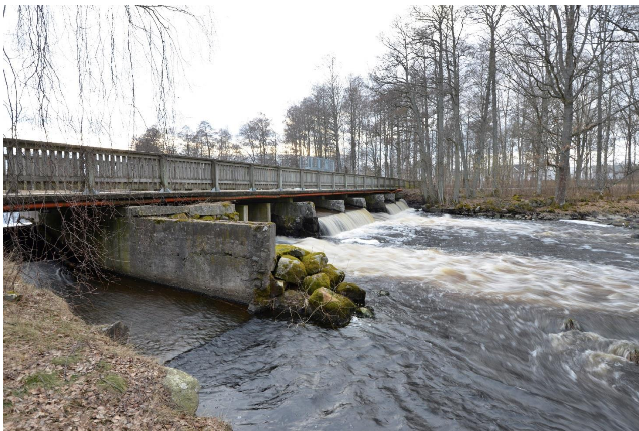
Figur 3. Dammen vid Mela kvarn i Emåns huvudfåra som regleras av Emåförbundet på uppdrag av Njudungs Energi AB. Foto: P. Johansson
