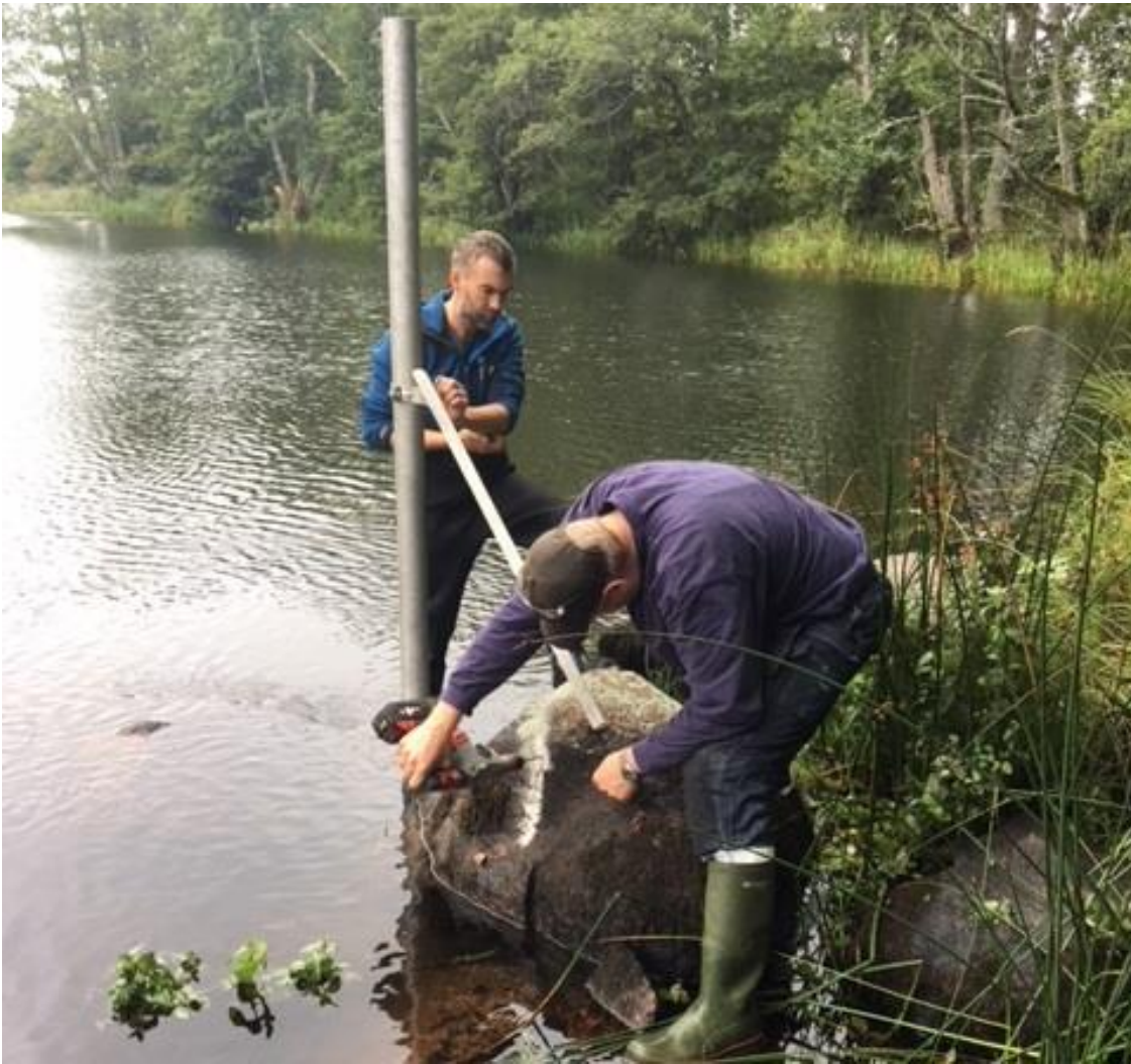
Figur 15. Installation av en ny vattennivåmätare i Emåns huvudfåra vid Grönskog i Mönsterås kommun. Foto: Ilan Leshem.
