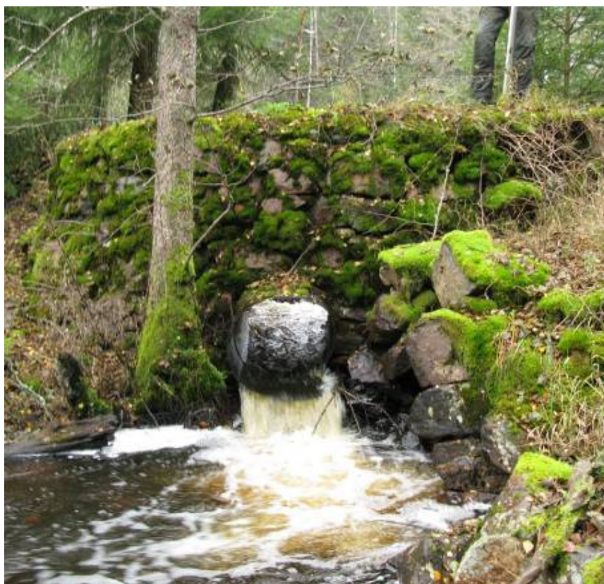
Figur 17. Vedermödan övre vid den senare dammen som byggdes i samband med turbinkraftverket. Röret är början på den tub som ledde till turbinen nedströms. Det gamla kvarnstället låg längre nedströms, dvs. lägre än nuvarande damm. Foto: T. Nydén.
