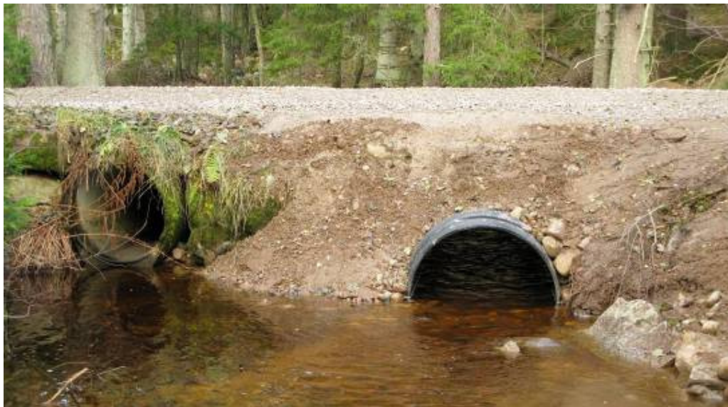
Figur 57. Exempel på vägtrumma (800 mm) med naturlig botten där den ursprungliga trumman lämnats kvar för att avbörda vid ev. höglöde. Foto: T.Nydén
