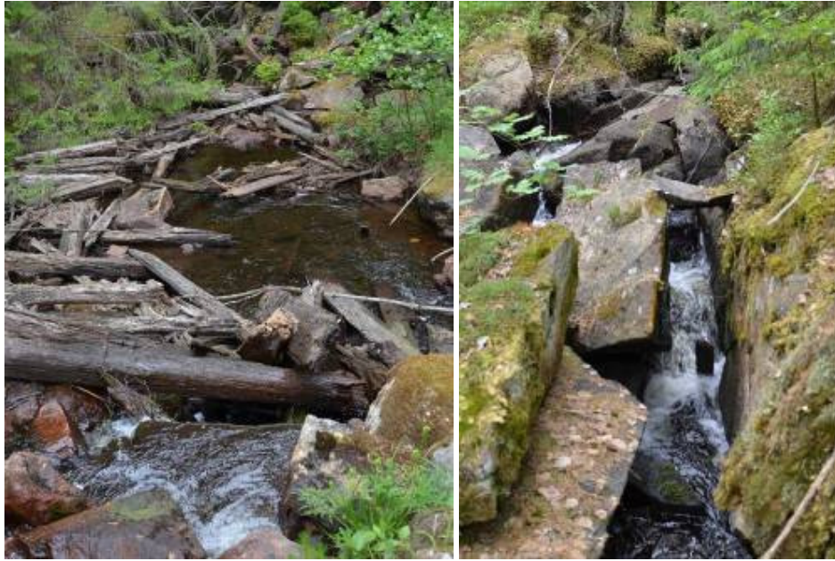
Figur 60. Södra utskovet (vänstra bilden) utgör definitivt vandringshinder medan norra utskovet (högra bilden) har åtgärdats så att öring kan ta sig förbi vid gynnsamma förhållanden. Emellertid har stenar lagts ut vid utskovet så att fisken i dagsläget inte kan passera.
