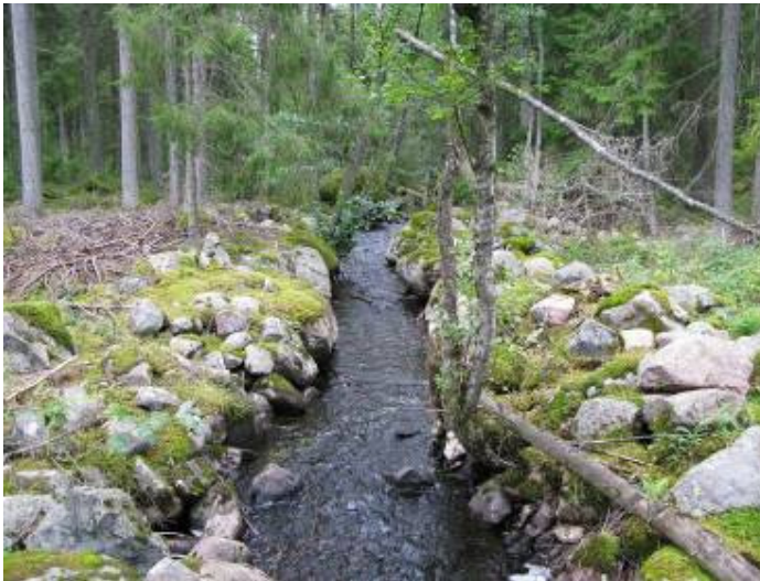
Figur 64. Den kallmurade kanalen som ligger uppströms kvarnstället.
