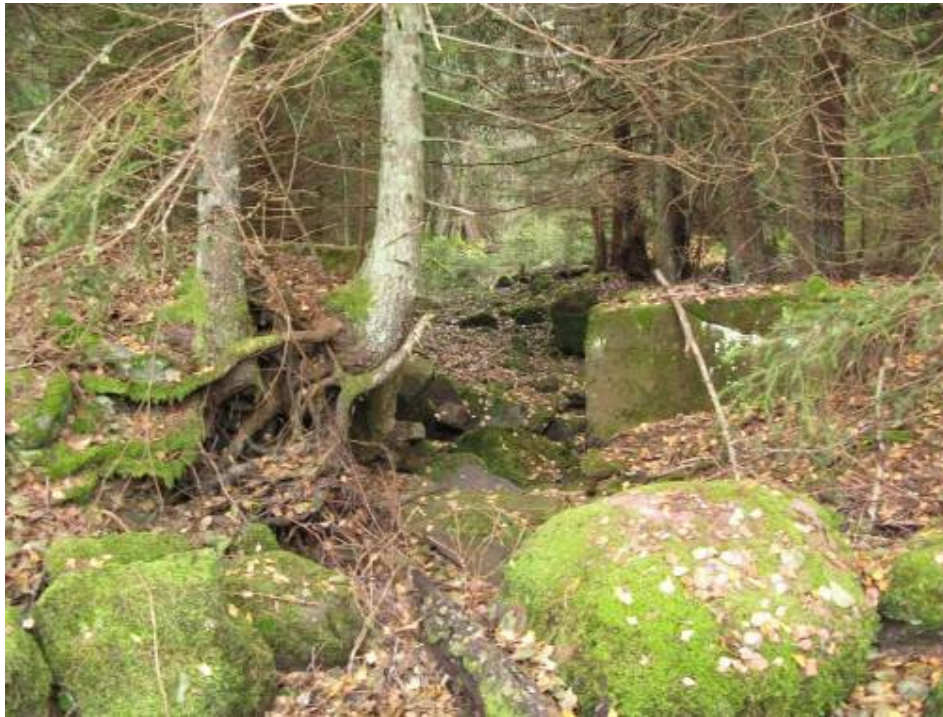
Figur 19. Breddutskovet vid sydöstra sidan av dammen vid Vedermödan. Här spilldes vatten vid breddning och en tillfällig åfåra skapades som mynnade i området kring Stjärnemosse. Foto: T.Nydén.
