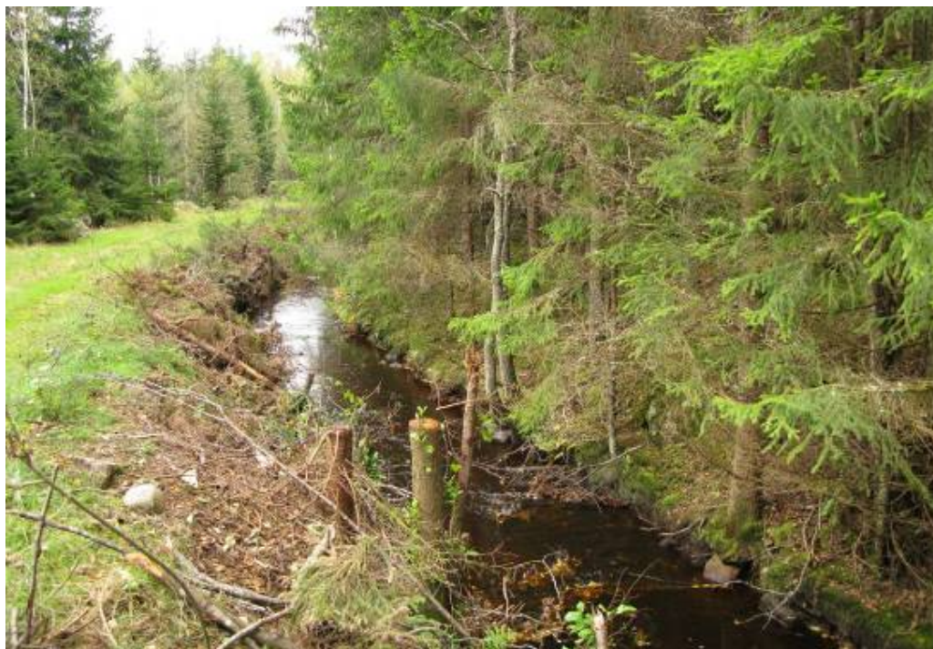
Figur 39. Lokal 3A; Kanalen nedströms mjölängarna. En sänkt och rätad del av Gnyltån som kan förbättras i viss utsträckning.
