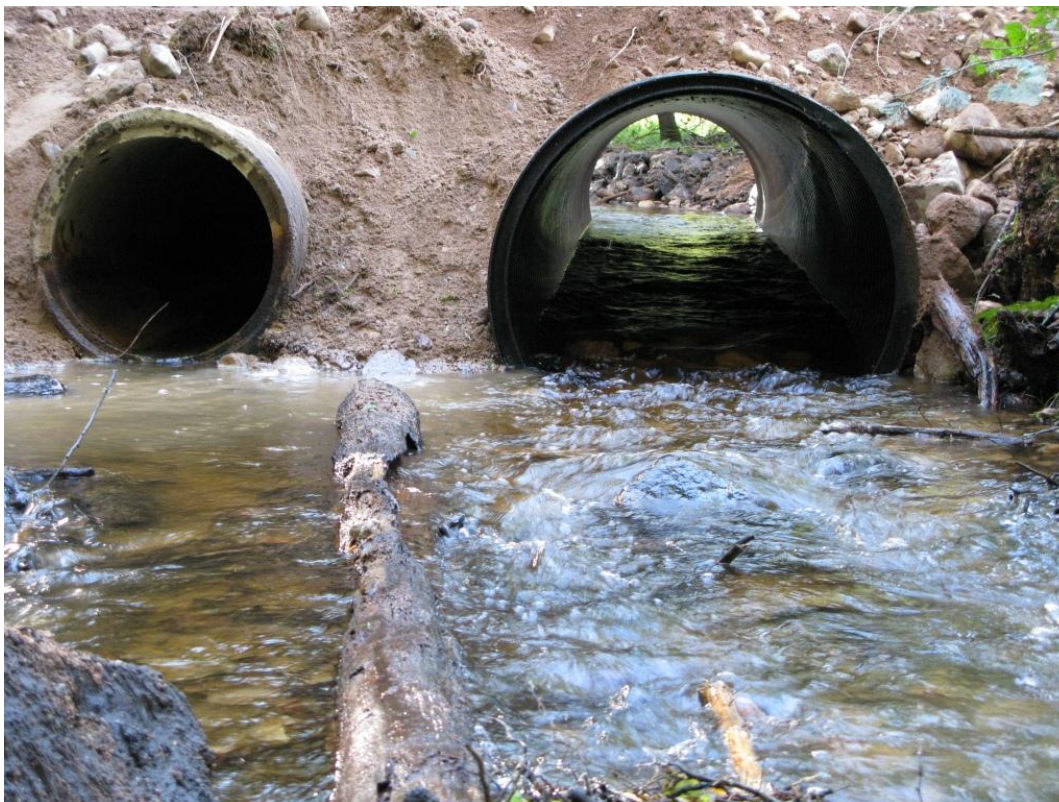
Vägtrumma 2 efter åtgärd, allt vatten rinner nu i den nya plasttrumman som har ett större djup och naturlig stenbotten, den gamla trumman avbördar vid högre flöden. Foto: T. Nydén.
