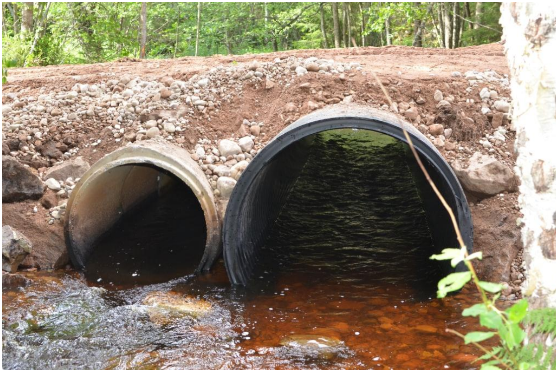
Vägrutrumma 1, efter arbetet. En betongtrumma har bytts ut mot en större plasttrumma med ett högre vattendjup. Sten har skottats in för att skapa en naturlig bottenprofil. Foto: P. Johansson.
