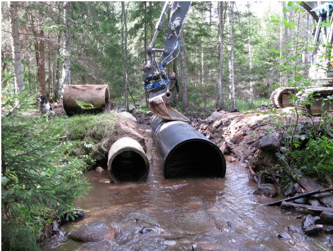
Vägtrumma 2, övre. En av betongtrummorna har grävts bort och grävmaskinen håller på att passa in plasttrumman. Foto: T. Nydén.
