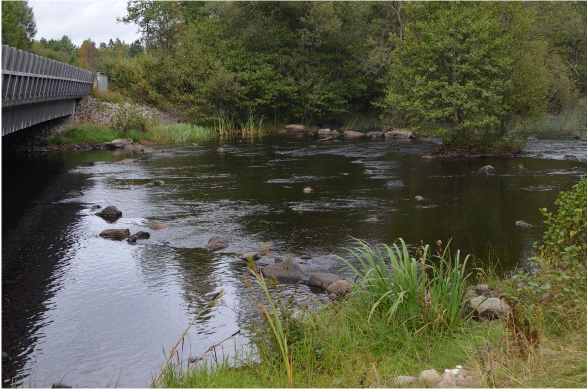
Åtgärdsområdet nedströms vägbron innan åtgärd, uppförda äldre strömkoncentratorer (stenrevlar) dämmer in området. Foto: P. Johansson.
