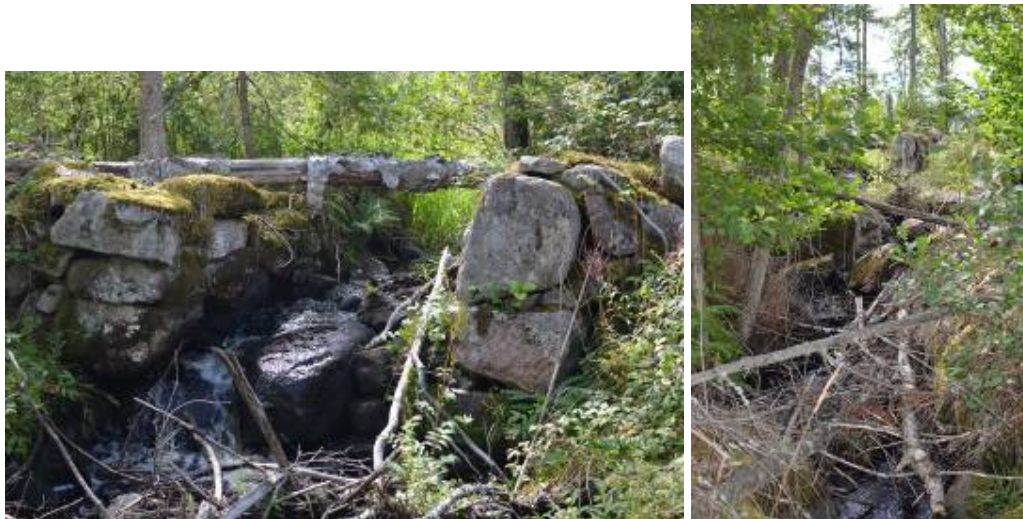
Figur 14 och figur 15. Rester efter gammal stendamm. Bäckan faller brant upp till dammkrönet, total uppskattad fallhöjd ca 4-5 m. Flera rester efter stenfundament m.m. Ett definitivt vandringshinder. Foto: P. Johansson.
