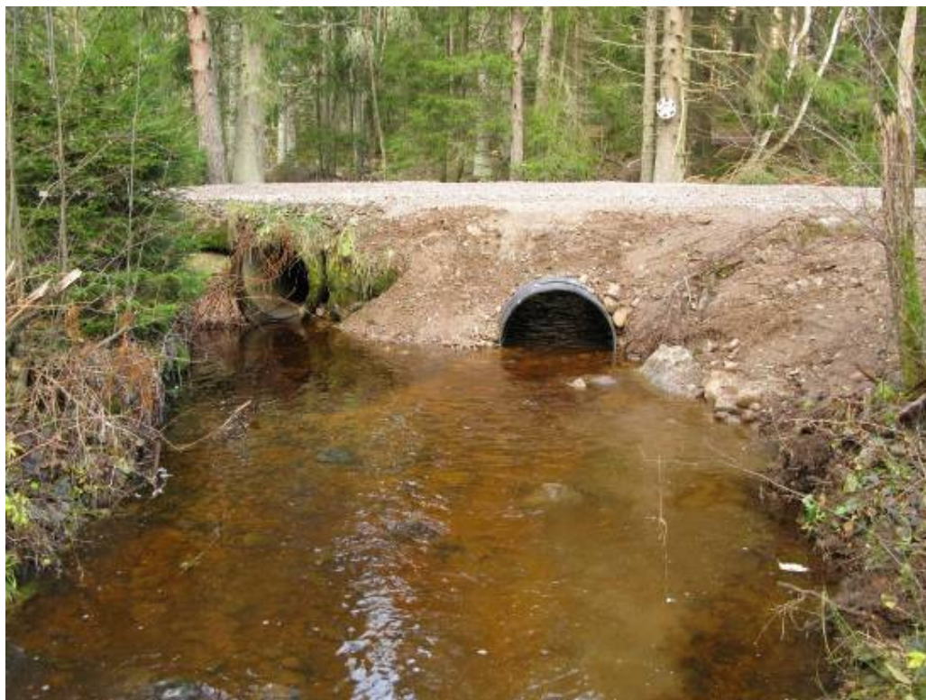
Figur 21. Exempel på byte av trumma i en mindre bäck (Brunnsbäcken 2010), en större plasttrumma har lagts bredvid en befintlig, botten består av natursten vilket skapar en bra faunapassage. Foto. T. Nydén.
