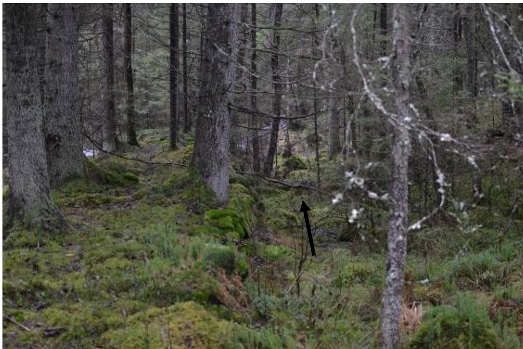
Figur 42. Dammvallens övre del på den östra sidan, bäcken ses i borte delen. Stendammen öppnas upp i förgrunden och vatten leds in till en ny fåra som löper utmed vallen (se pil) ner till bäcken. Foto: P. Johansson.
