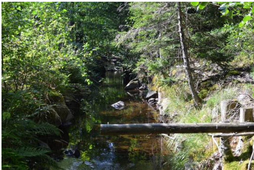
Figur 34. Kraftigt rensat parti, här föreslås att man lägger tillbaka block från kanterna för att få en större variation i bäckfåran. Där det är möjligt att komma intill med maskin och där det finns förutsättningar för ett lekområde sprids leksten ut.
