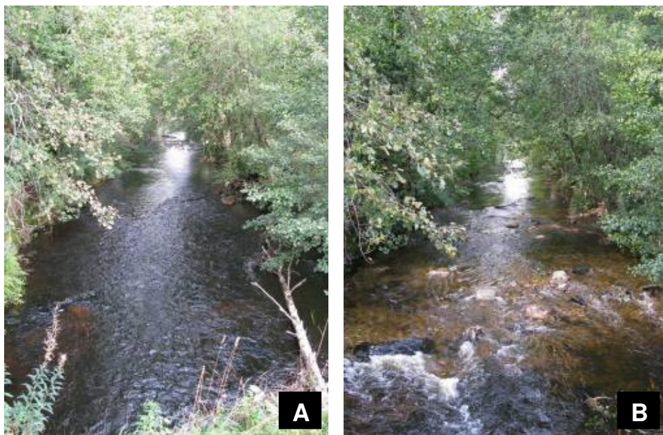
Figur 51. Exempel på genomförd biotopvård i en sänkt kanal utförd med en bandgående grävmaskin. Bild A: före åtgärd, bild B: block och sten har lagts ut, därefter dressas botten med lämpligt lekgrus. Målet är att få ett så naturligt utseende som möjligt. (den stora döda vedbiten flyttades nedströms då den låg för nära vägtrumman) Foto: T.Nydén
