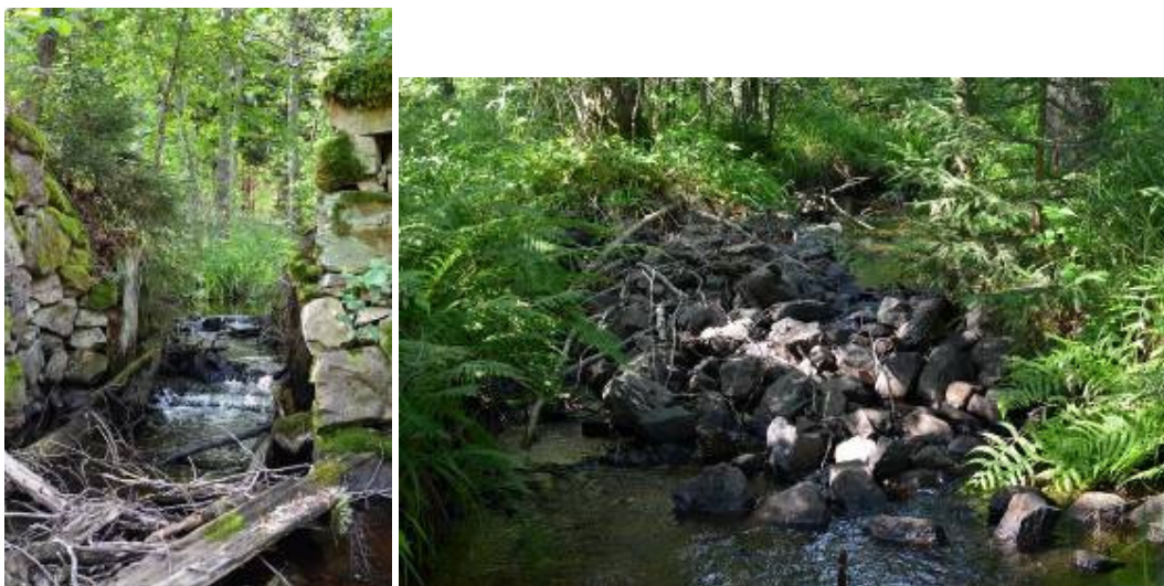
Figur 32 och figur 33. Den gamla (mäktiga) stendammen vars utskov nu är helt utrivet och medger fri fiskpassage. Strax uppströms finns en sten- och blocksamling i bäcken som vid rådande vattenföring utgör ett svårpasserbart vandringshinder. Enkelt att riva ut för hand. Foto: P. Johansson.
