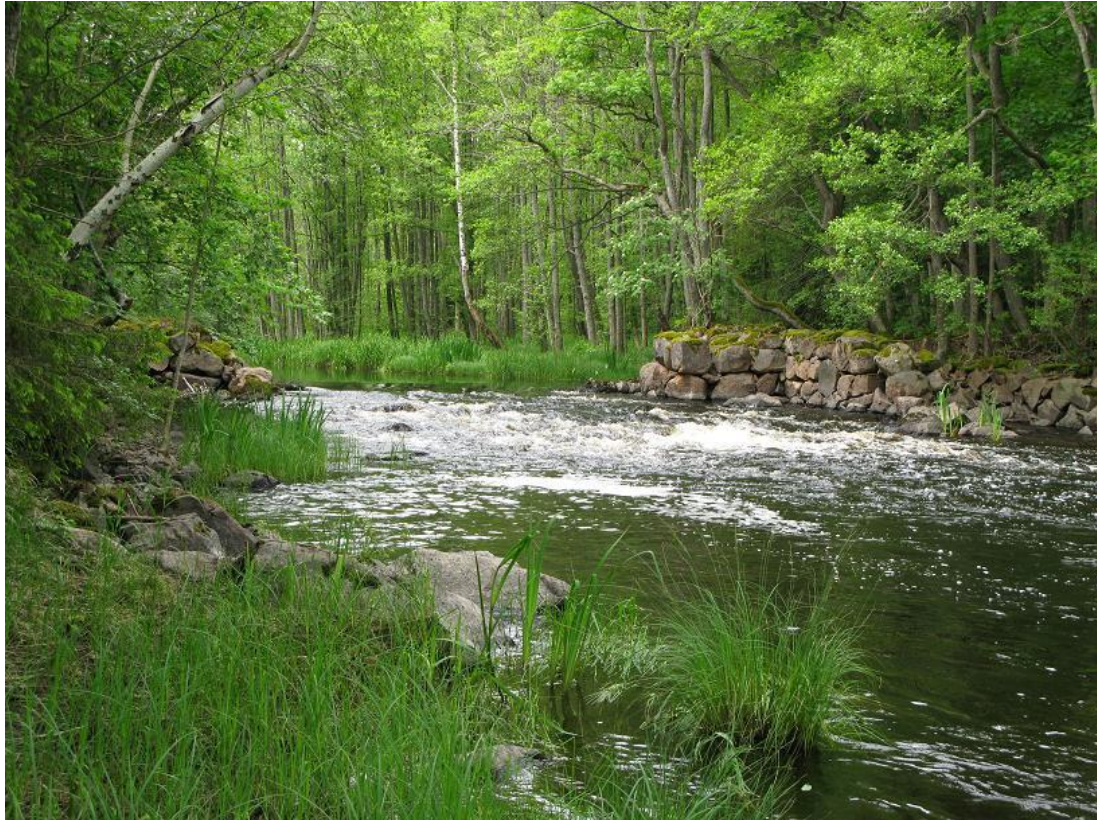
Figur 9. Gamla stensättningar rester efter damm. Åtgärdslokal 1C (Foto: T. Nydén).
