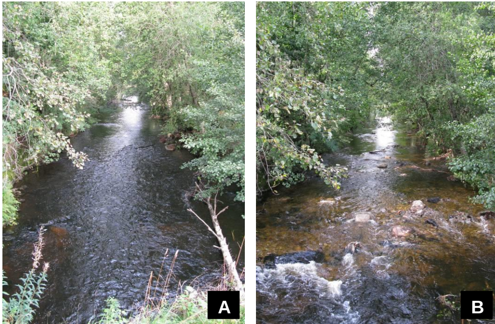
Figur 47. Exempel på genomförd biotopvård i en sänkt kanal utförd med en bandgående grävmaskin. Bild A: före åtgärd, bild B: block och sten har lagts ut, därefter dressas botten med lämpligt lekgrus. Målet är att få ett så naturligt utseende som möjligt. (den stora döda vedbiten flyttades nedströms då den låg för nära vägtrumman) Foto: T.Nydén
