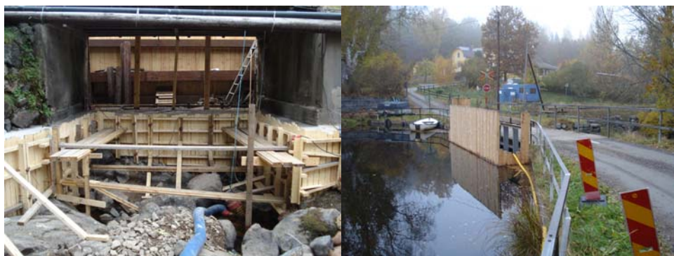
Figur 3. renovering av dammfästet vid Hjorteström.
