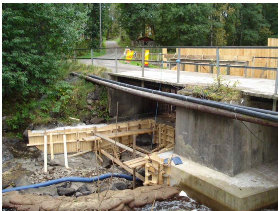
Renoveringsarbete vid Hjorteström august- september 2009.
