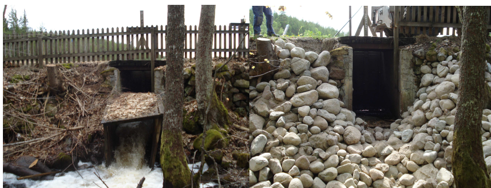
Figur 3. Reparation av utskov vid Flenhult kvarndammen, sommaren 2011. Bilden tv. innan och th. efter reparationen.
