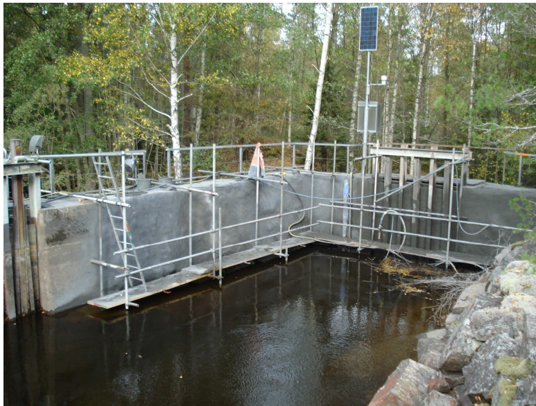
Figur 4. Renoveringsarbete i Saljens dammfäste, oktober 2011.
