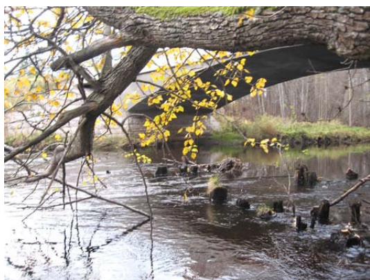
0-10 m nedströms bron.
