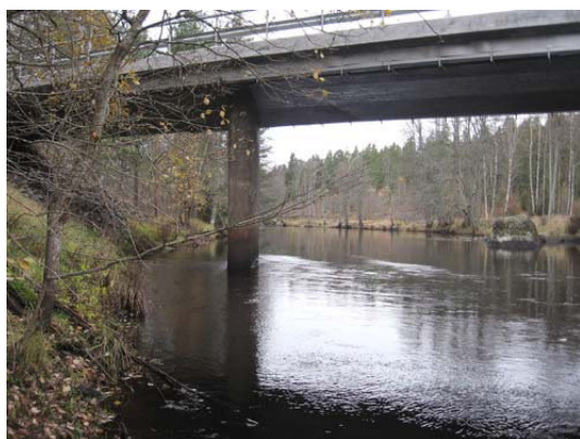
5-15 m nedströms bron, längs västra kanten.
