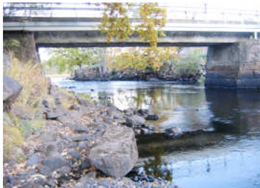
5-15 m uppströms bron på norra sidan.
