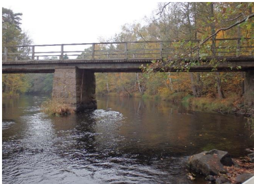
0-10 m nedströms bron.
