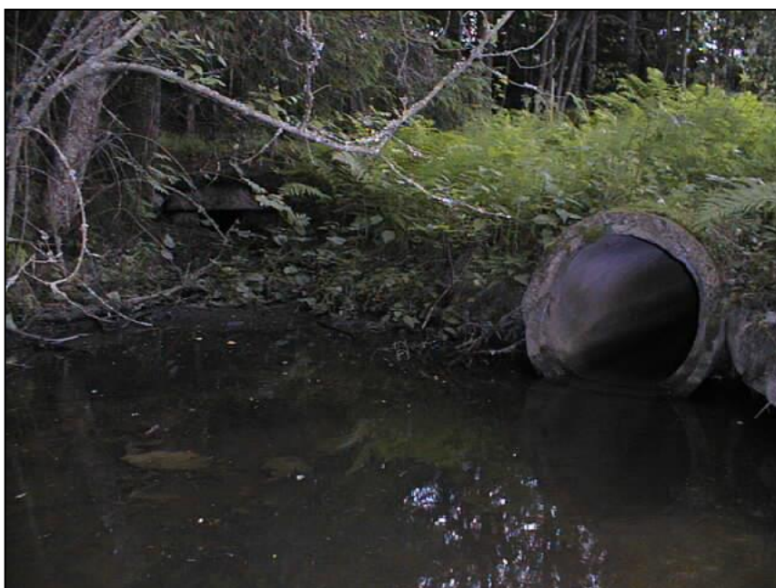
Bild 50. Det befintliga utloppet i dagvattenområde B 1.
