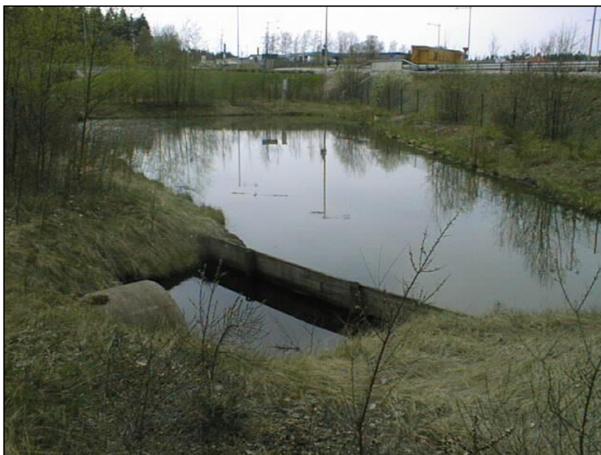
Bild 19. Befintlig dagvattendamm med oljefilter i förgrunden strax framför utloppet.
