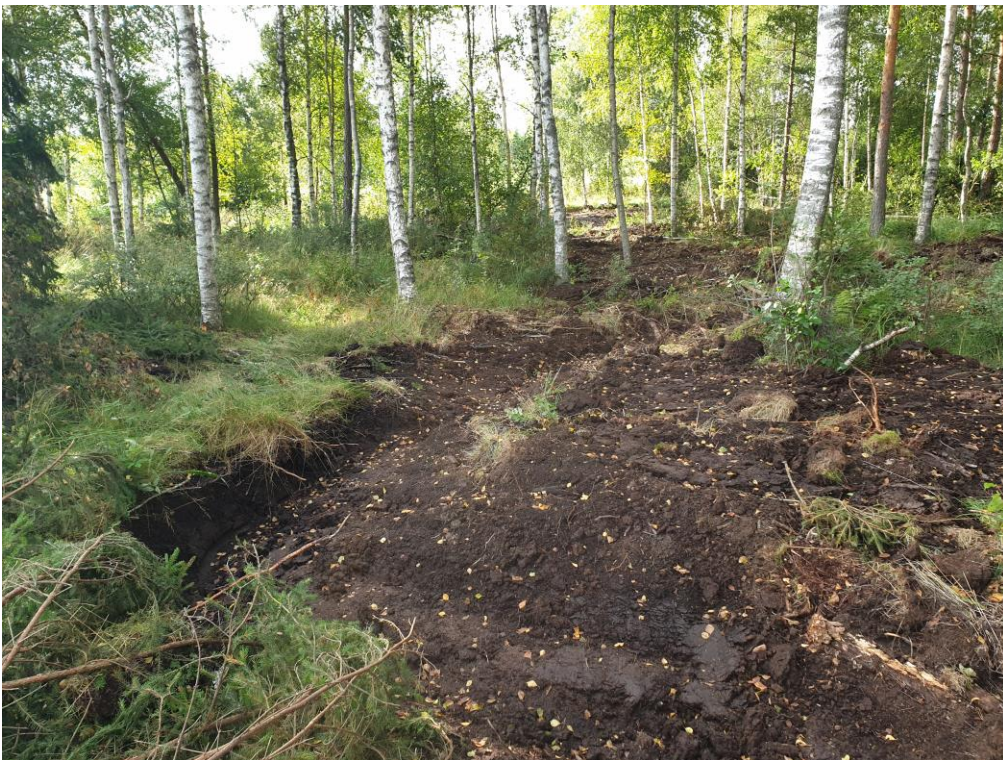
Figur 14. Diket grävdes slingrande genom björkskogen, med varierad bredd och djup. Massorna jämnades ut längs sidorna.
