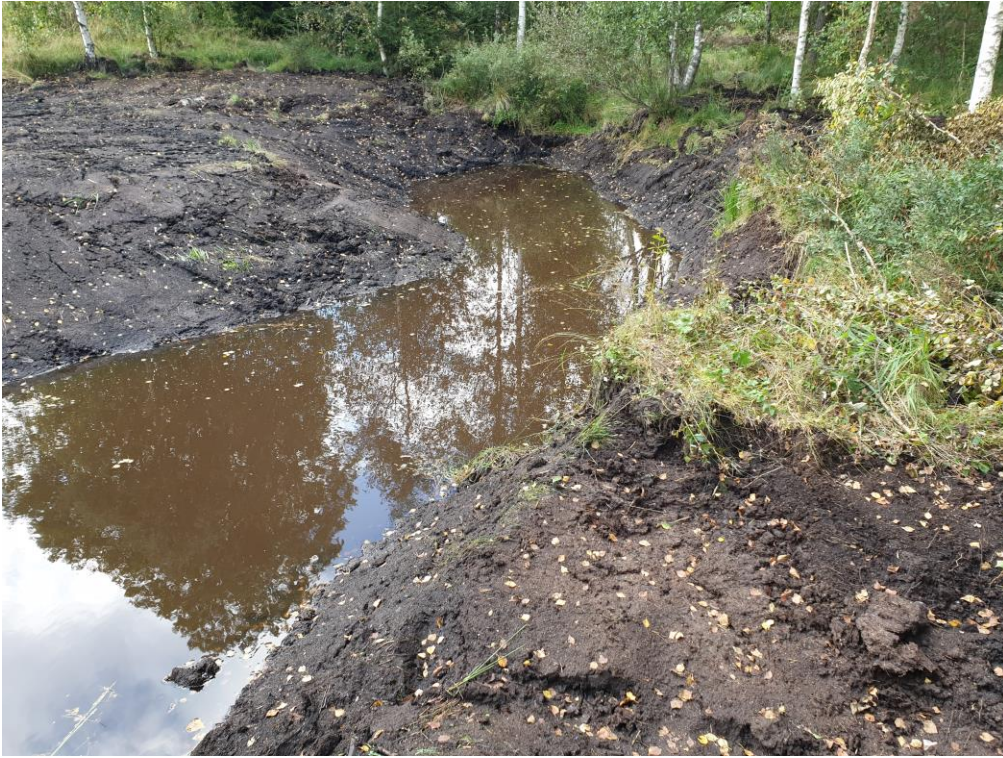
Figur 13. Det nya slingrande diket tog sin början vid en gammal sedimentationsdamm. Tröskeln lades ca 30 cm över rådande grundvattennivå, för att skapa en vattenuppehållande effekt.
