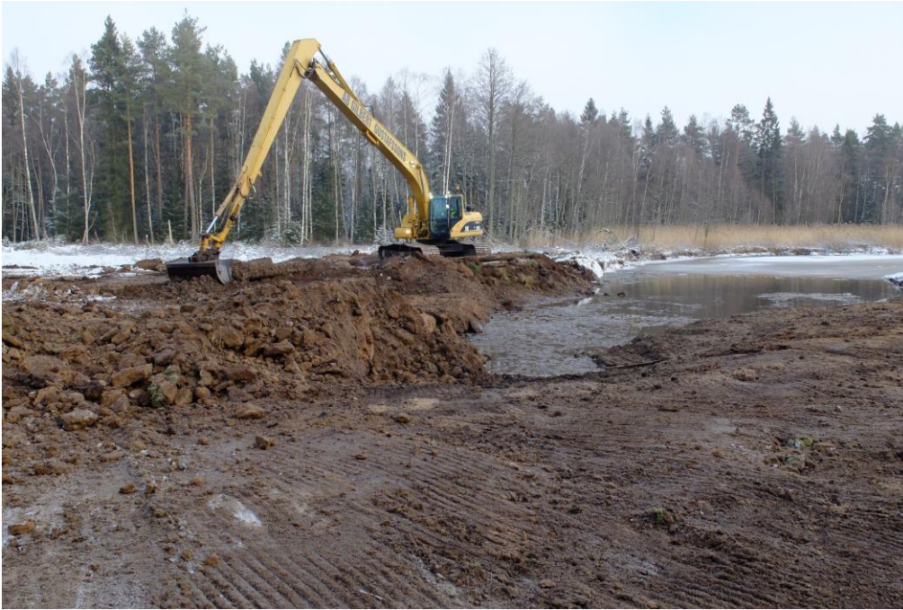
Figur 5. En långgrävare gav förutsättningar att nå ut långt på den tidigare sjöytan och flytta massorna successivt bakåt.
