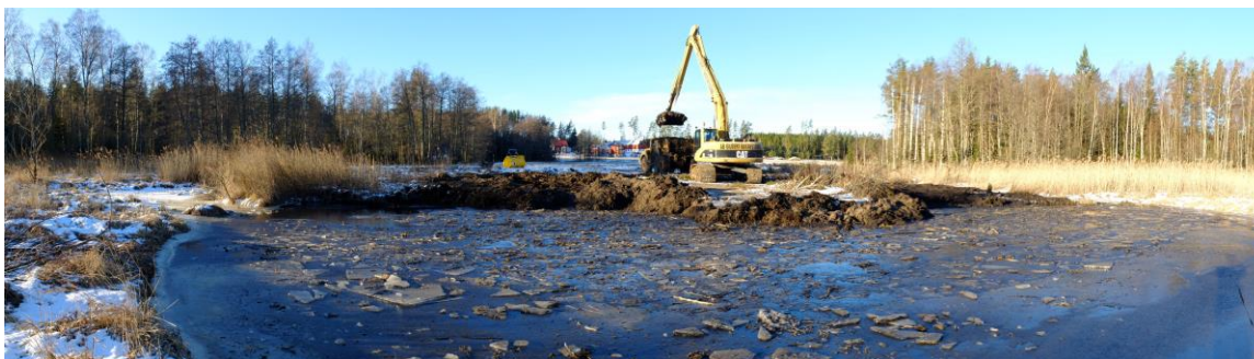
Figur 4. Första delen av åtgärdsarbetet bestod i att gräva upp en ca 3000 m 2 yta av den ursprungliga bocksjön. Massorna lastades på dumper och fraktades ca 100-200 m bort i väntan på bandschaktmaskin.
