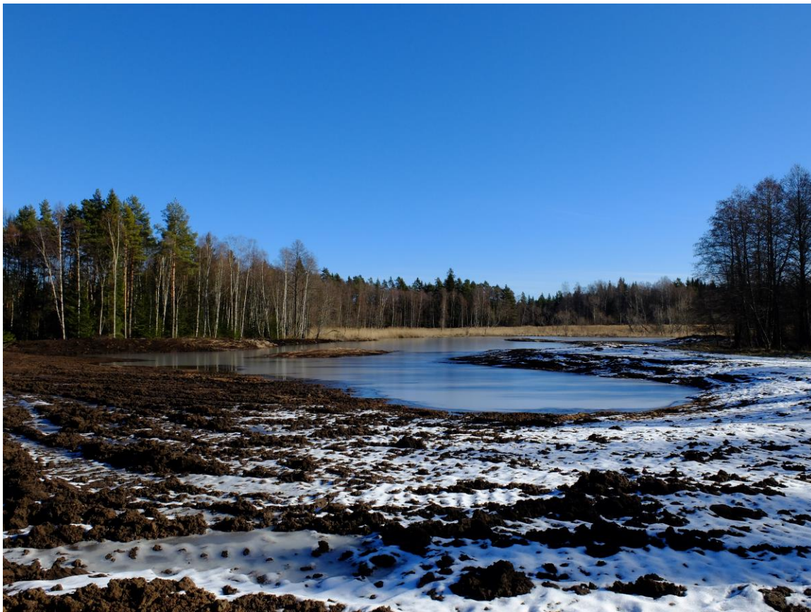
Figur 11. Den grunda delen av området som utgör svämplan och våtmark var till stora delar färdiggrävd i slutet av februari. De flacka slänterna jämnades sedan ut ytterligare med bandschaktmaskin.
