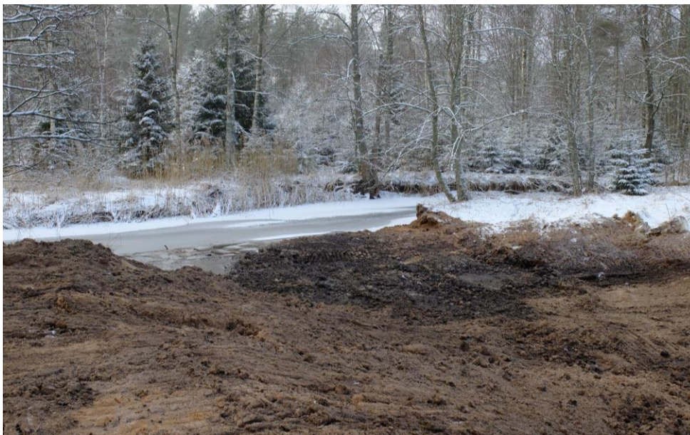
Figur 7. Grundtröskeln, som utgör det egentliga inflödet till nya delen av Bocksjön och svämplanet gjordes ca 10 m bred. Fotot visar grundtröskeln 23 januari, då flödet enligt SMHI hype var ca 1,3 m 3 /s i Fuseån.
