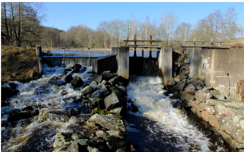
Figur 2. Dammfästet vid den övre dammen i Åhult, sedd från nedströmssidan vid en vattenföring på ca 1,7 m 3 /s. (Foto: Emåförbundet).
