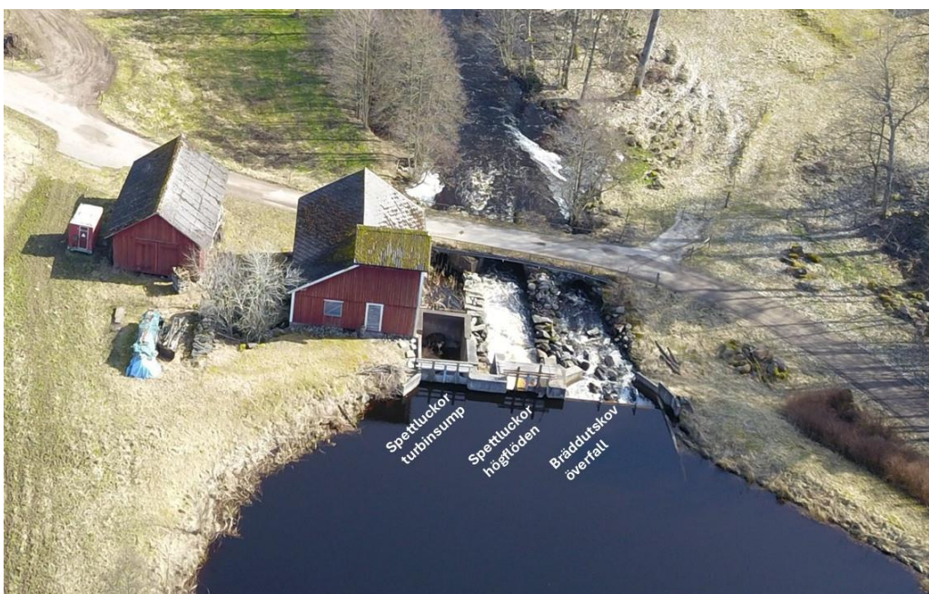
Figur 4. Övre dammen i Åhult, sedd från uppströmssidan med beskrivning på respektive utskov.
