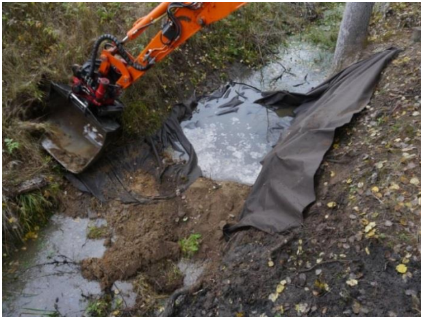
Lägg ut en duk, lägg i jordmassor som innesluts o blir dämmet
