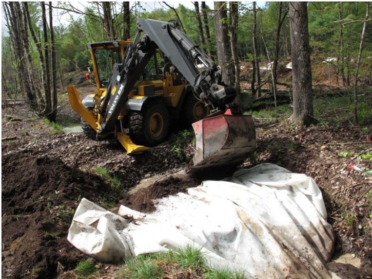
Dämme byggs med makadam, grus o duk Vattnet leds förbi dämnet i gammal fåra
