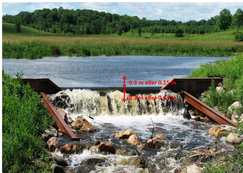
Figur 9-2. Illustration av dämme med undre och övre magasin. Bildkälla okänd.
