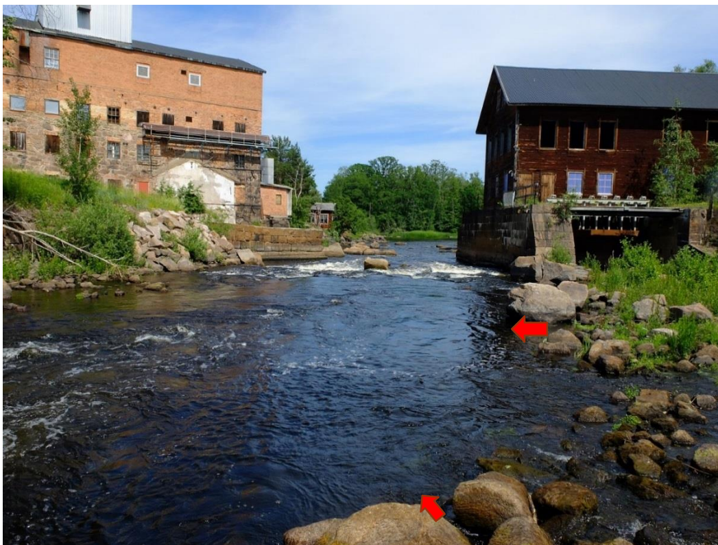
Figur 26. Stenmaterialet längs södra kanten mellan de uppbyggda strömnackarna kan läggas ut i åfåran så att fallprofilen utjämnas och breddas och även det södra området blir vattenförande.
