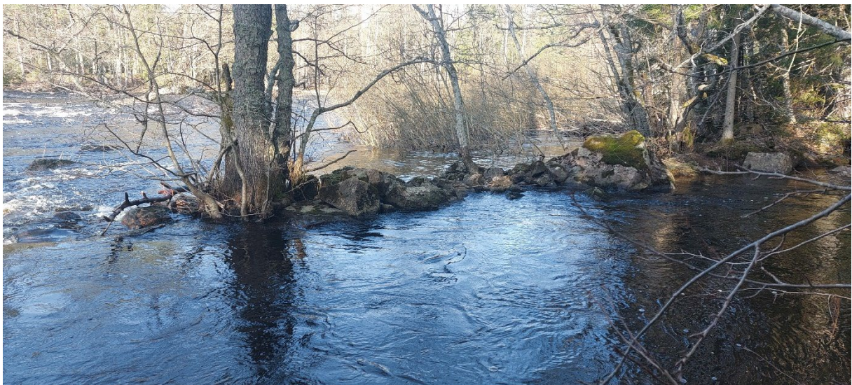
Figur 5. Den bevarade ledarmen som styrt in vattnet i kanalen.
