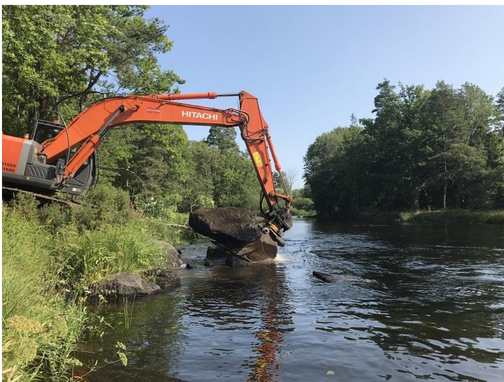
Figur 16. Utplacering av upprepade stora block i huvudfåran
