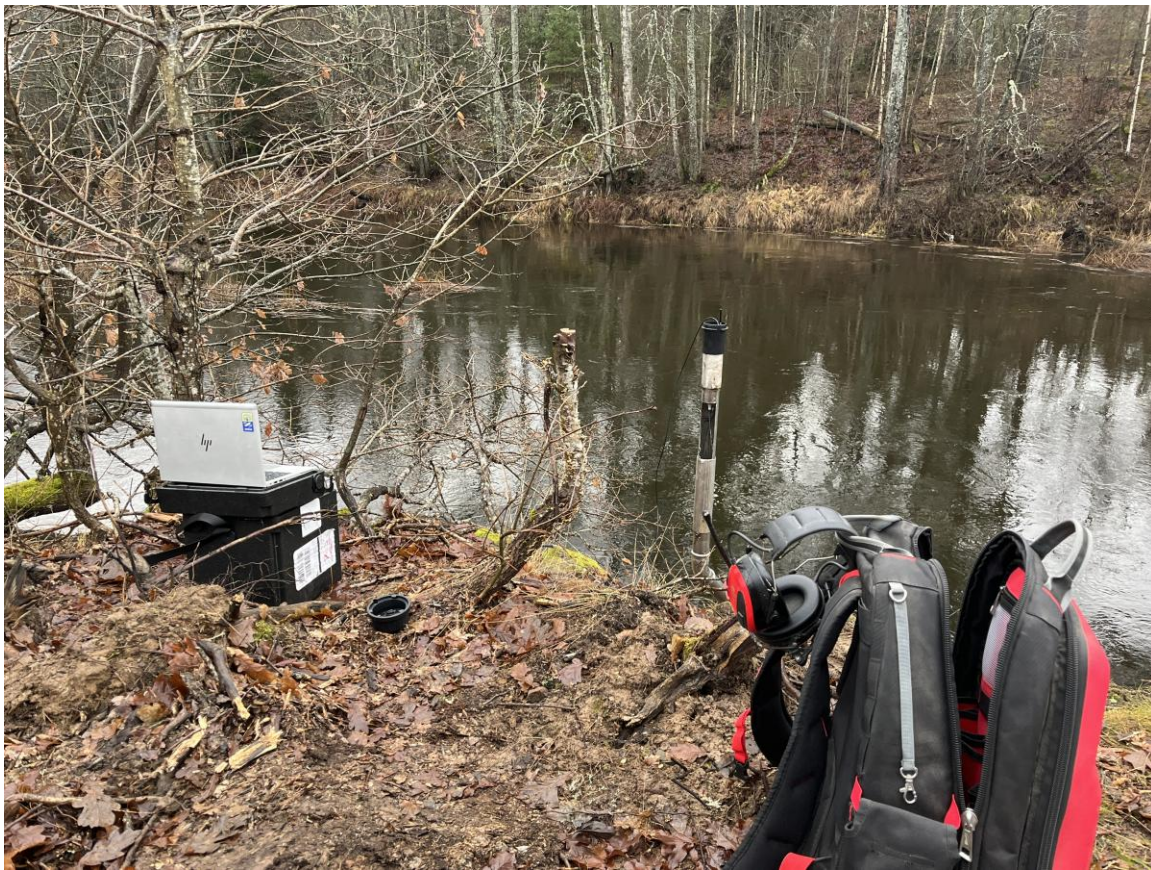
Figur 5. Installation av ny mätstation i den nedre delen av Emån 2025. Nya stationer kommunicerar via 4G.
