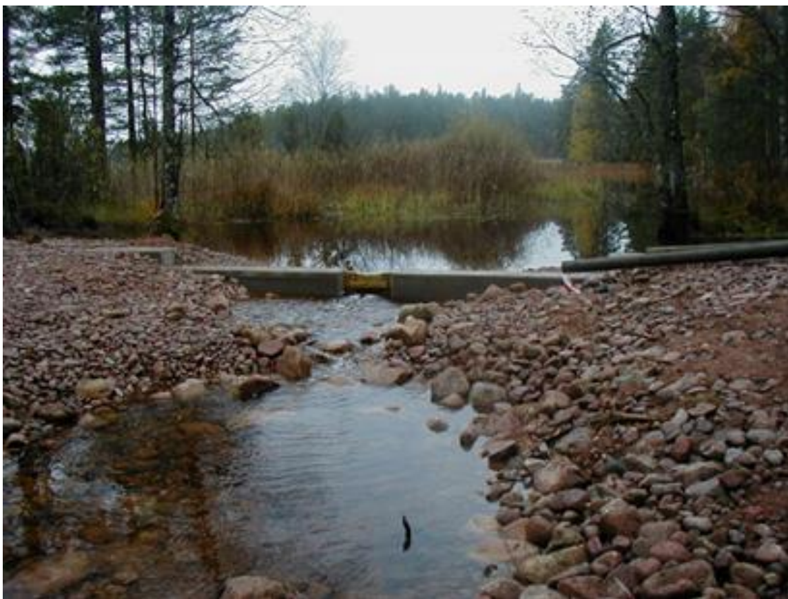
Figur 25. Utloppet från sjön Boen i Silverån utgör ett exempel på ett lågt skibord med ett bottenutskov för en bättre vattenhushållning. Detta utskov byggdes i början på 2000-talet och har enligt fiskevårdsområdet fungerat väl.
