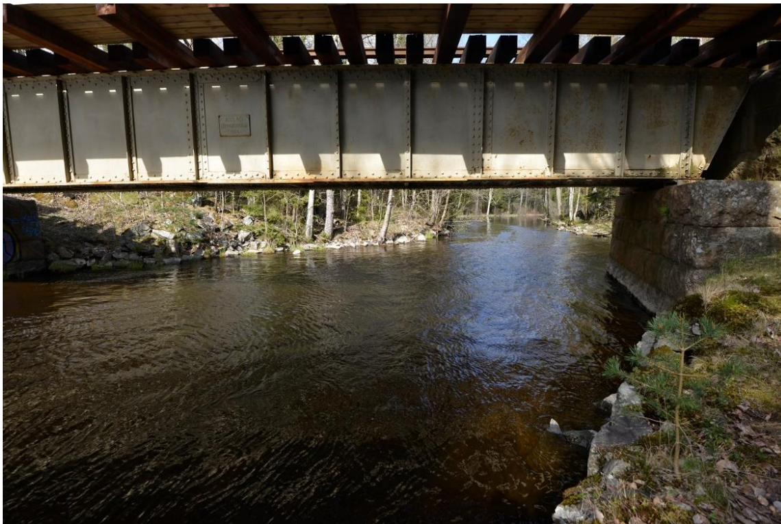
Figur 12. Nömmens utlopp vid järnvägsbron. Nässjö-Vetlanda banan, invigd 1914.
