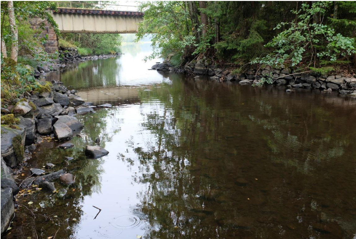
Figur 4. Nömmens utlopp är kanalliknande med en slät bottenprofil.
