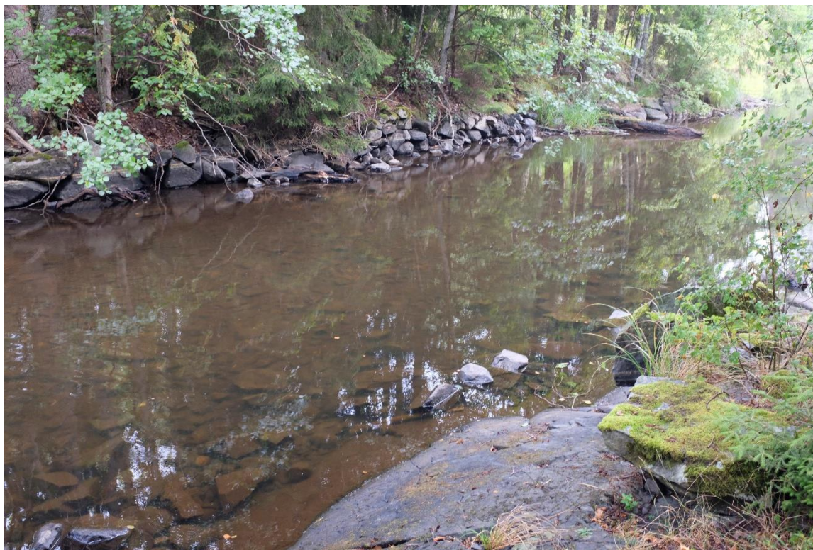
Figur 14. Det rensade partiet nedströms järnvägsbron som mätts in med tvärsektioner (2-4). Notera den jämna bottenprofilen.
