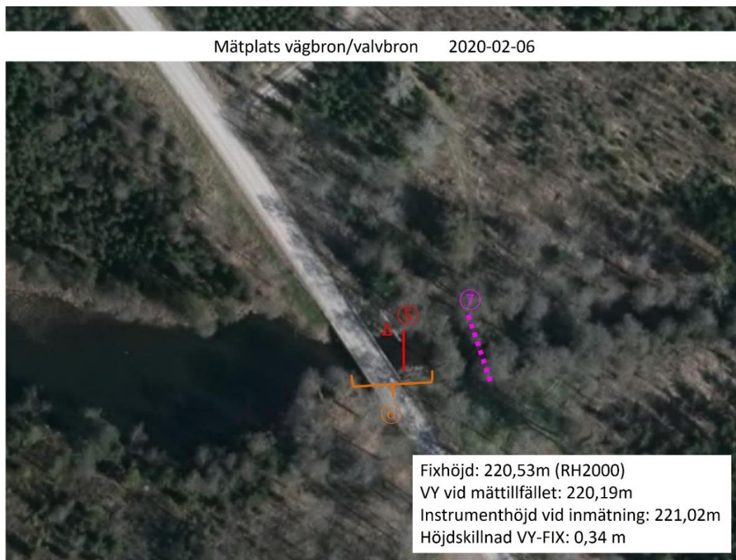
Figur 15. Inmätt tvärsektion vid vägbron, sektion 5 redovisas i bilaga 1.
