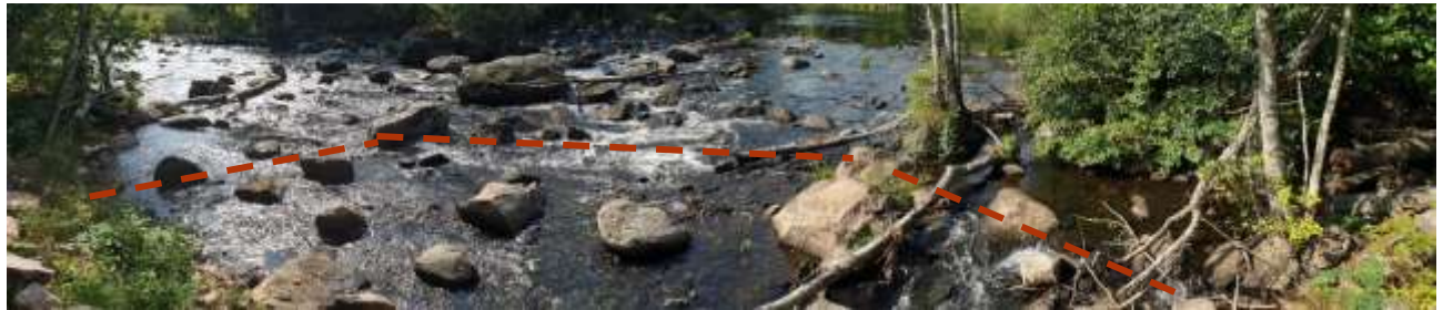
Figur 11. Foto på Gunnarsfors i Grönskogsområdet. Elfiskelokalen: 4, är markerad med streckad linje. Platsen är relativt svårtillgänglig via stig. Sträckan är total restaurerad med grävmaskin 2019. Foto: T. Nydén.
