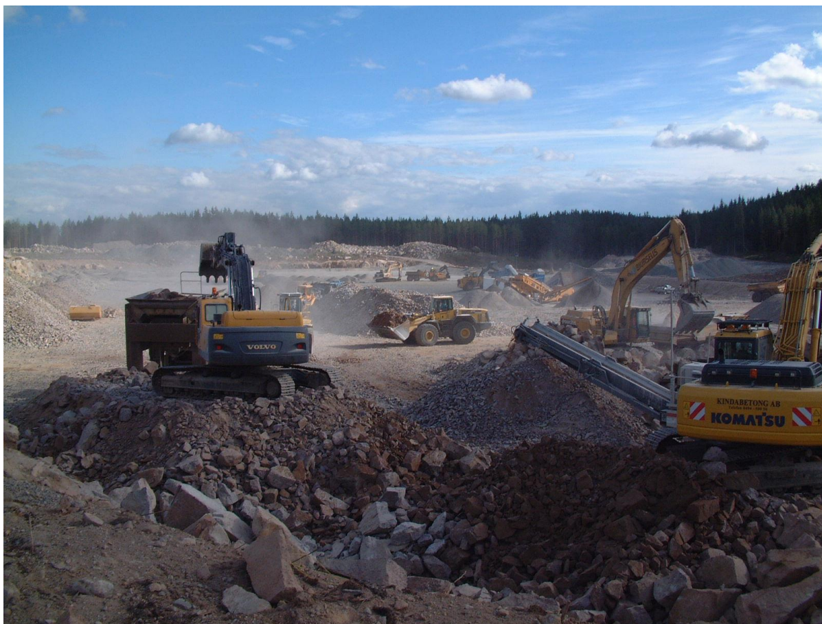
Figur 3. Iordningsställande av deponibotten.
