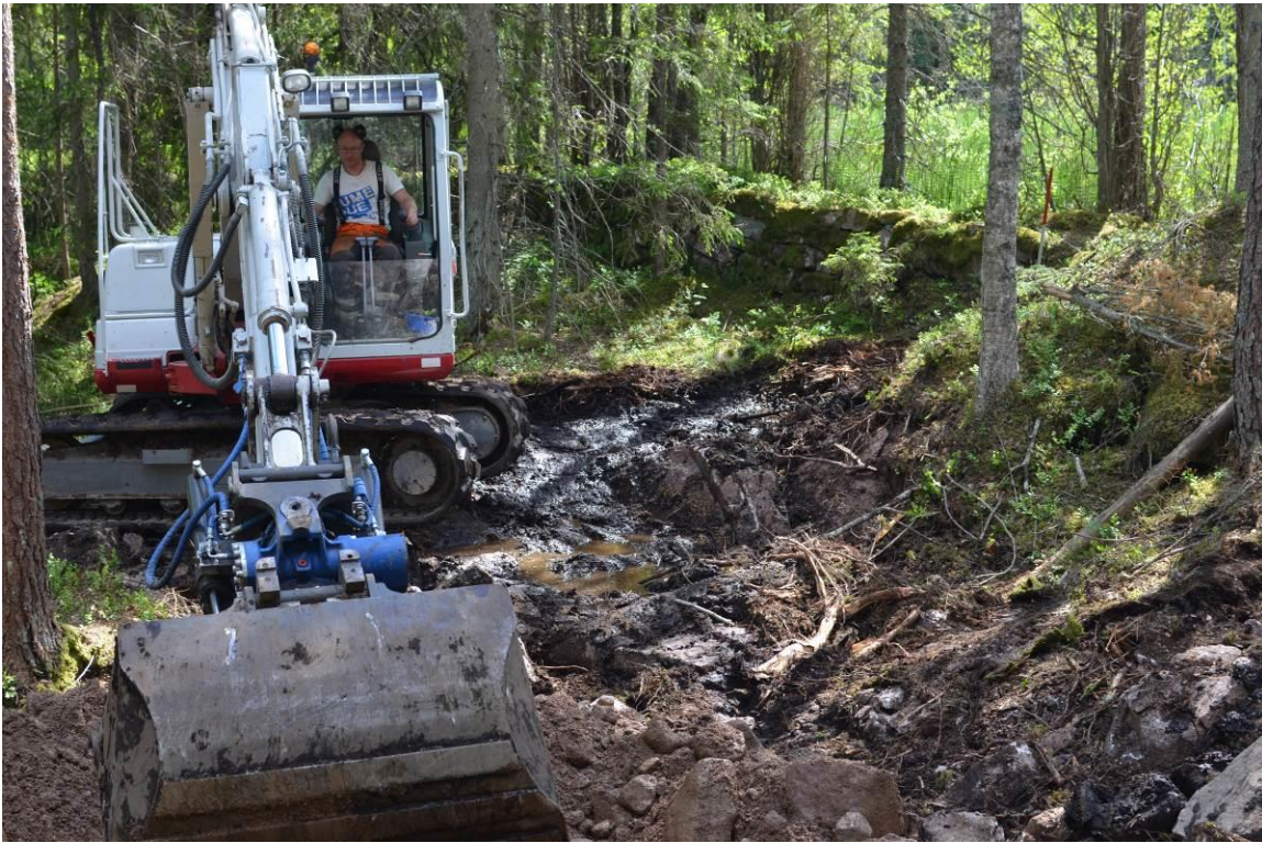
Figur 5. En fiskväg grävs i Gnyltån sommaren 2013.
