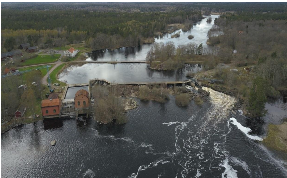
Figur 8. Karlshammars kraftverk som utgör det första vandringshindret i Emån. Foto: T. Nydén.
