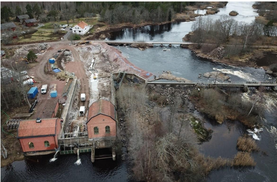
Figur 9. Byggnationen av en ny faunapassage vid Karlshammars kraftverk påbörjades under hösten 2019 och innebär ett omfattande entreprenadarbete av NCC. Emåförbundet ansvarar för design och funktion på uppdrag av Södra Cell Mönsterås. Drönarbild: Emåförbundet.
