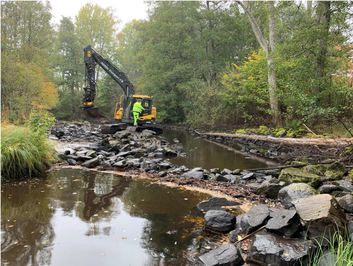
Figur 17. En hårt rensad sträcka restaureras i Badebodaån i Grönskåra. Foto: J. Nilsson.
