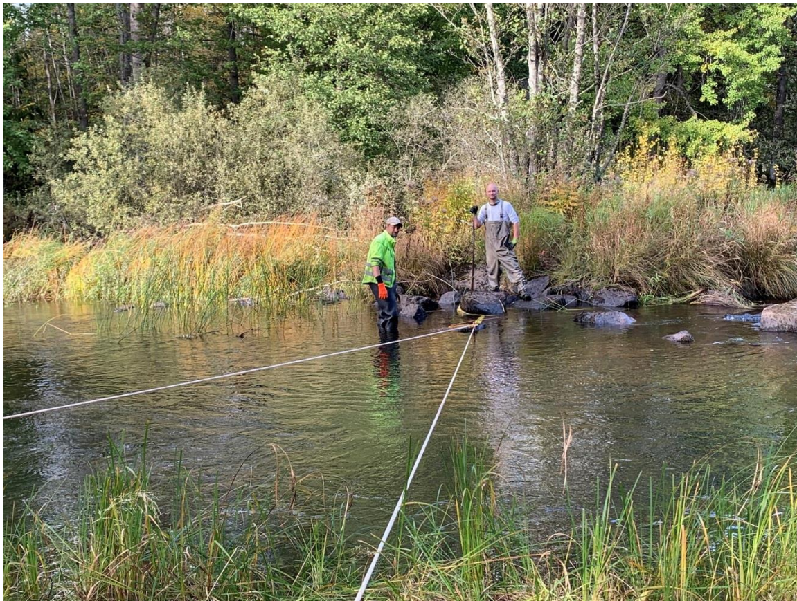
Figur 16. En hel del biotopvårdsarbete har genomförts i Grönskogsområdet under 2019. Till största delen har det inneburit manuellt arbete med hjälp av portabel motordriven vinsch, för att återutlägga uppnäsat blockmaterial på svåråtkomliga platser. Foto: J. Nilsson.
