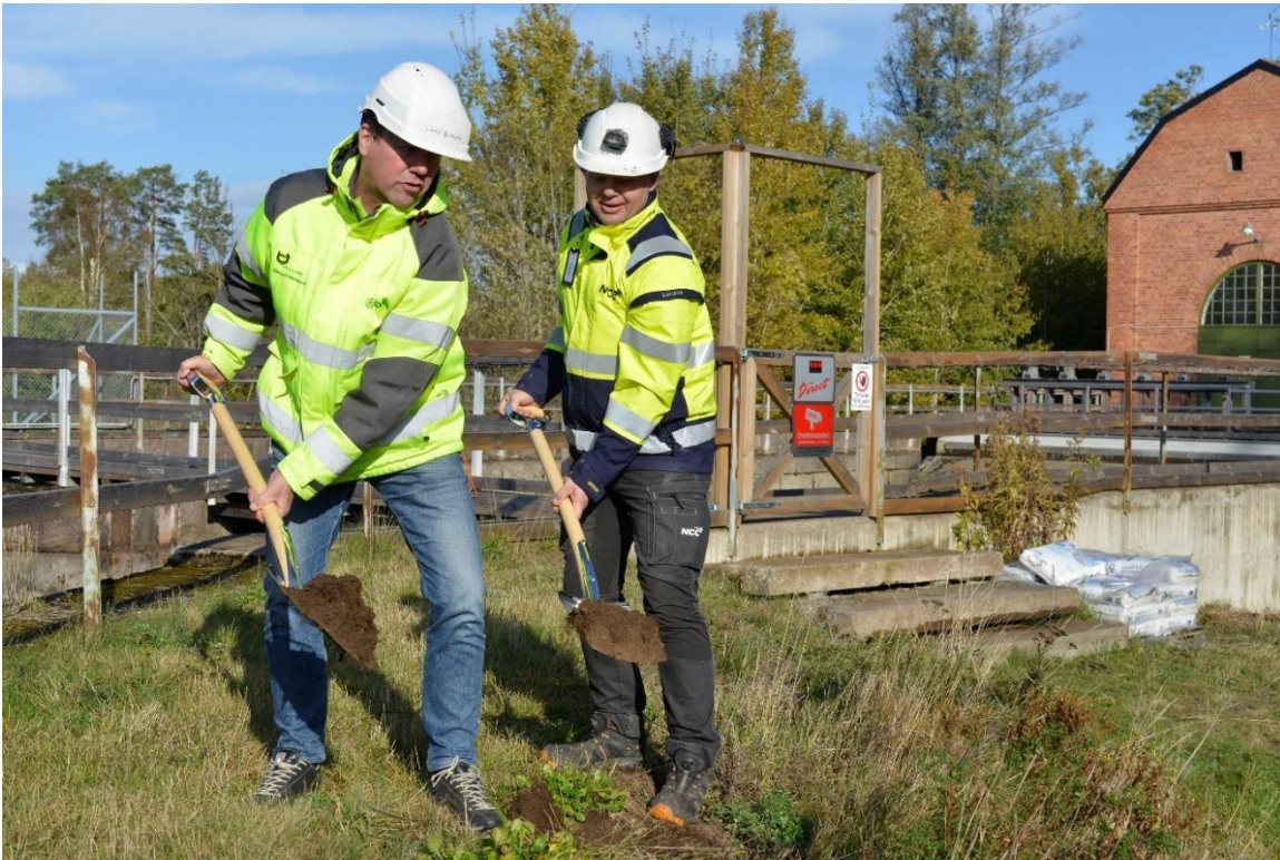
Figur 8. "Första spadtaget" för byggnationen av faunapassagen vid Karlshammar togs den 11 oktober. Foto: P. Johansson.
