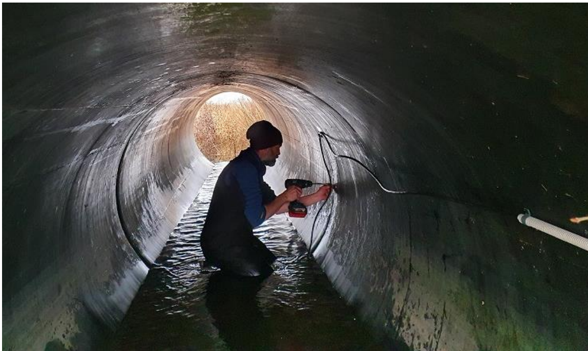
Figur 26. Jens Nilsson installerar en ultraljudsgivare för mätning av vattenförling inne i en kulvert mitt i det öländska jordbrukslandskapet vintern 2020. Foto: P. Johansson.
