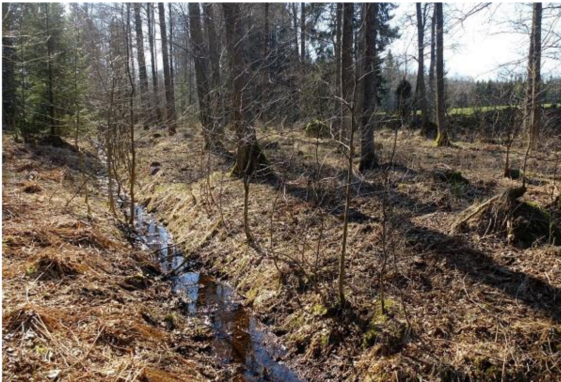
Figur 8. Ett utdikad alkärr. Inom projektet gallrades först granen bort och diket lades sedan igen med grävmaskin under våren 2020. Foto: P. Johansson.
