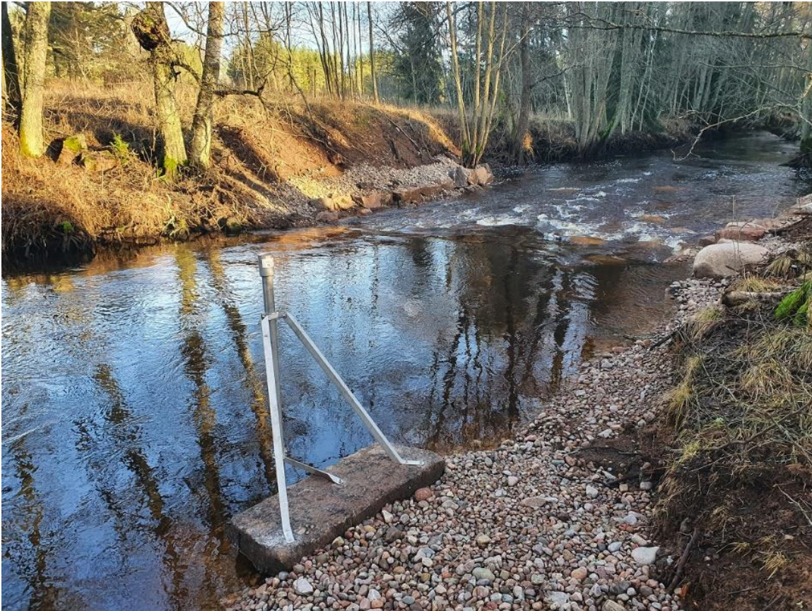
Figur 7. Restaurerad strömnacke i Fuseån med en ny flödesmätningstation i förgrunden.
