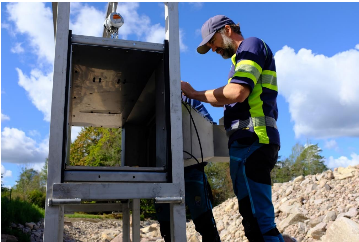
Figur 22. Fiskräknaren, som ska sitta i faunapassagen i tre år, installeras av Emåförbundet i september 2020. Foto: P. Johansson.
