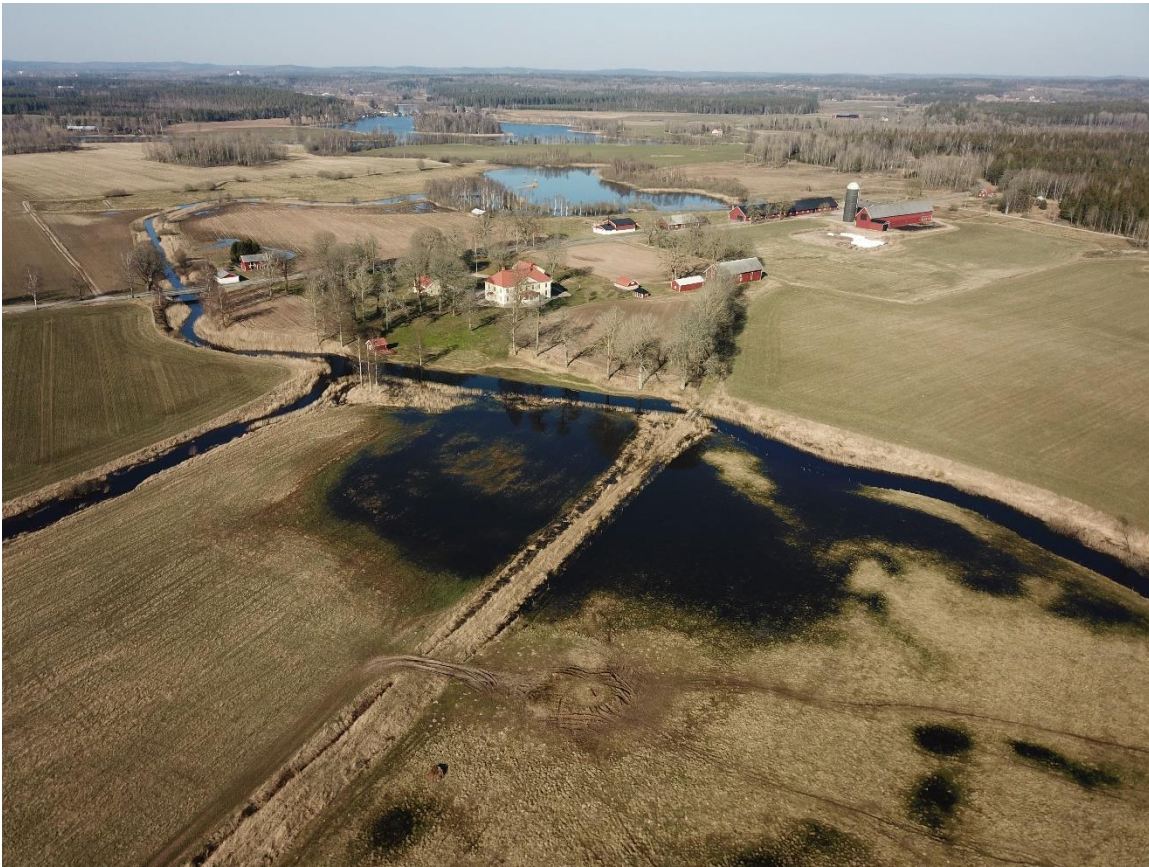
Figur 10. Foto över fastigheten Ryningsholm våren 2020 vid högflöde i Fuseån och kanalen från Ingatorpssjön. Det finns goda förutsättningar att skapa flertalet permanenta våtmarkslägen på fastigheten.
