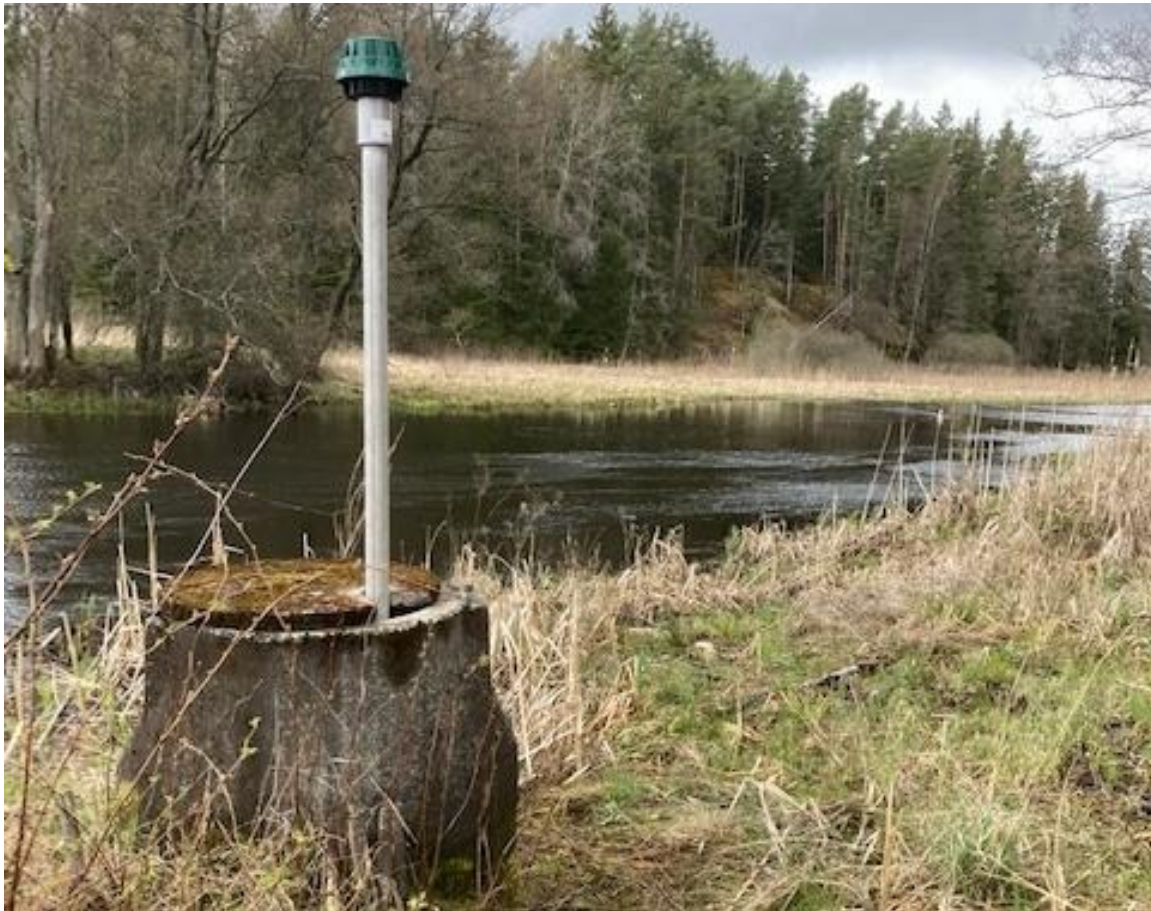
Figur 19. Flera nivå- och flödesmätstationsstationer etablerades under 2021. På bilden en ny mätstationsutrustning som ersatt den gamla vid nedre delen av Solgenån. Foto: I. Leshem.
