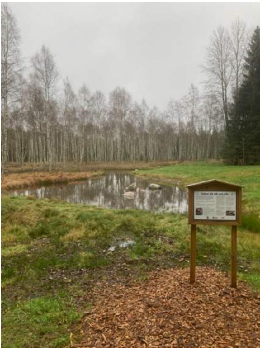
Figur 11. Våtmarksområde som färdigställdes 2021 som tar hand om vatten från nyetablerat handelsområde innan det rinner ut i Lövhultsbäcken.
