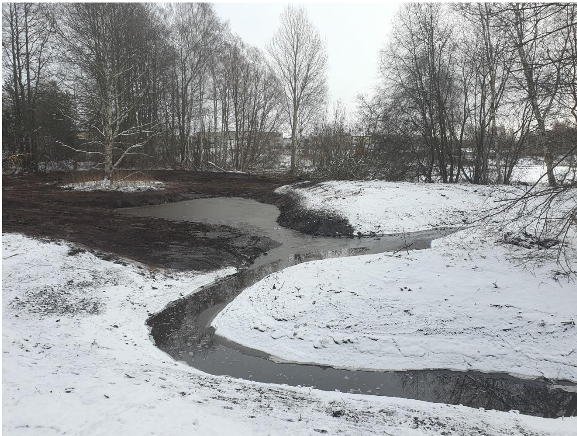
Figur 10. Under senhösten 2022 slutfördes ett av LOVA projekten med att en mindre våtmarksyta skapades genom omgrävning av ett dike vid Nannylund i Eksjö.
