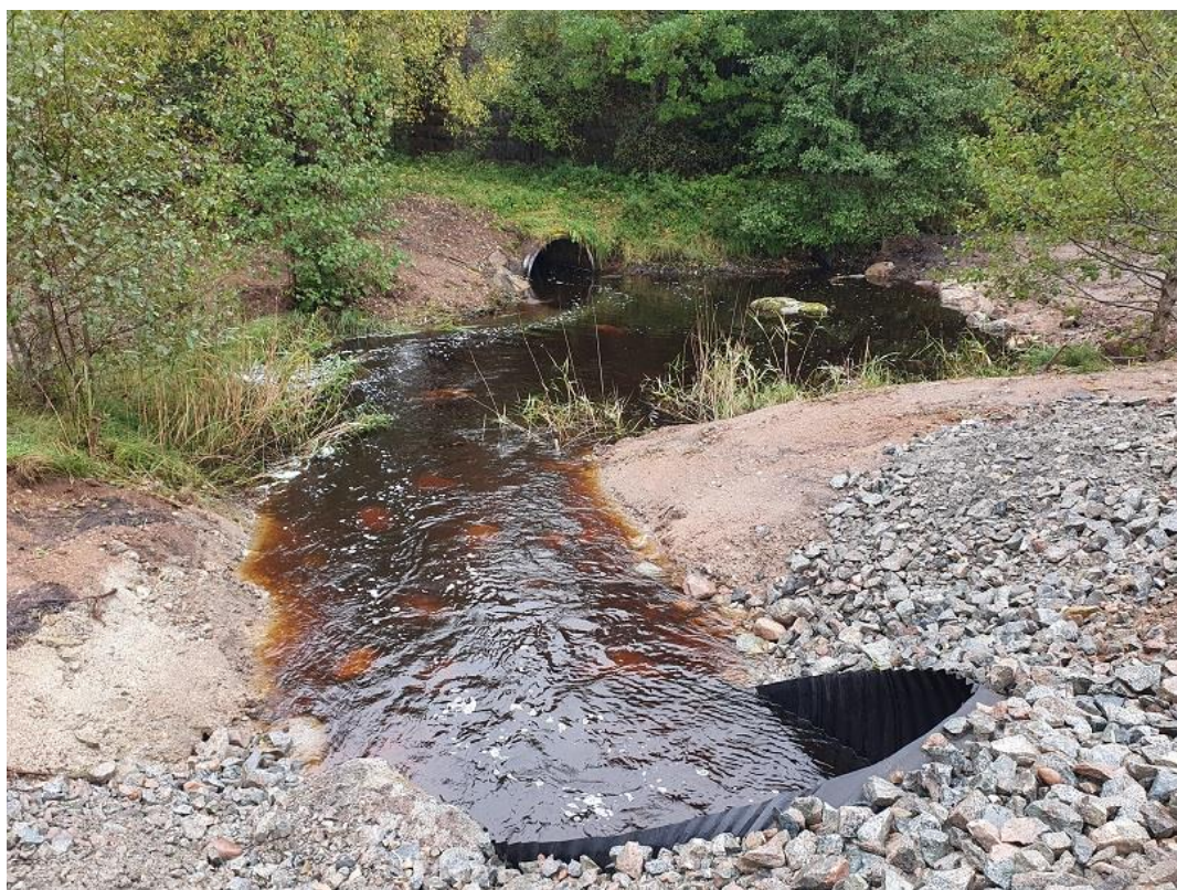
Figur 17. Emåförbundet var sakkunnig vid avsänkning av en damm i kombination med omgrävning av Stampån i syfte att återskapa konnektiviteten i vattendraget.
