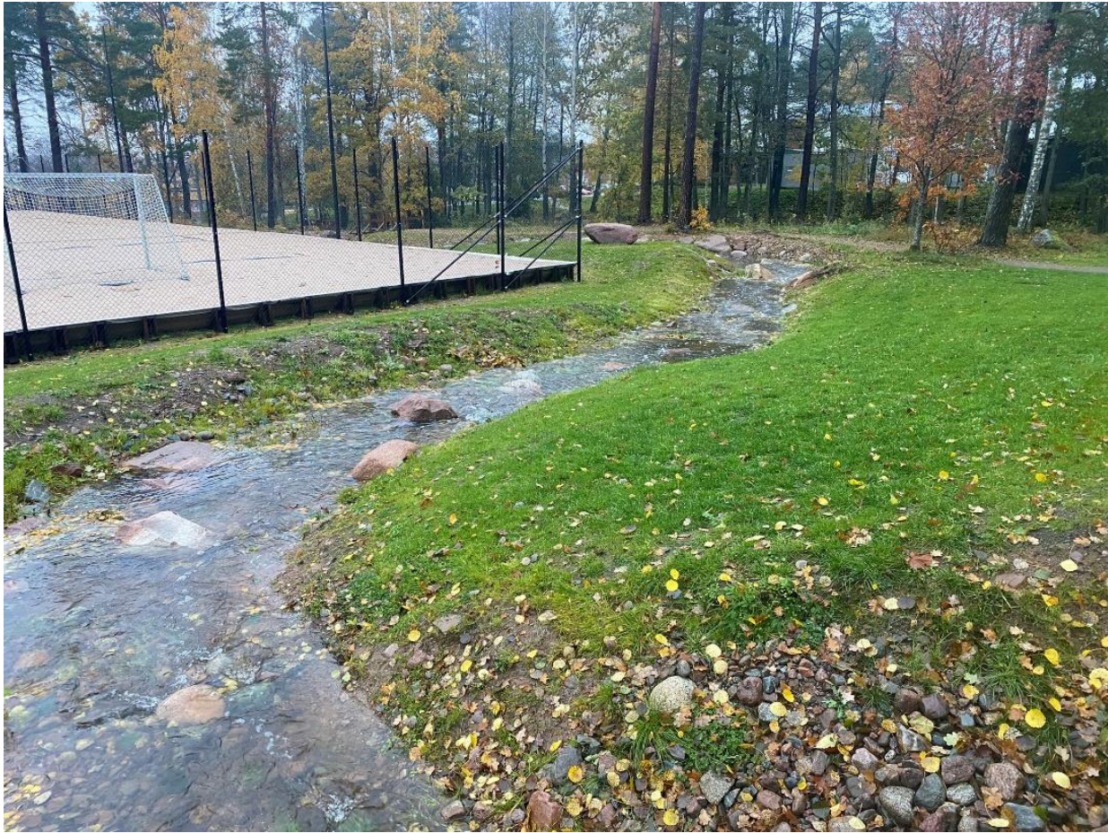
Figur 9. Hagadalsbäcken slingar sig nu via en ny faunapassage förbi Sågdammen i Hultsfred. Foto: J. Nilsson.
