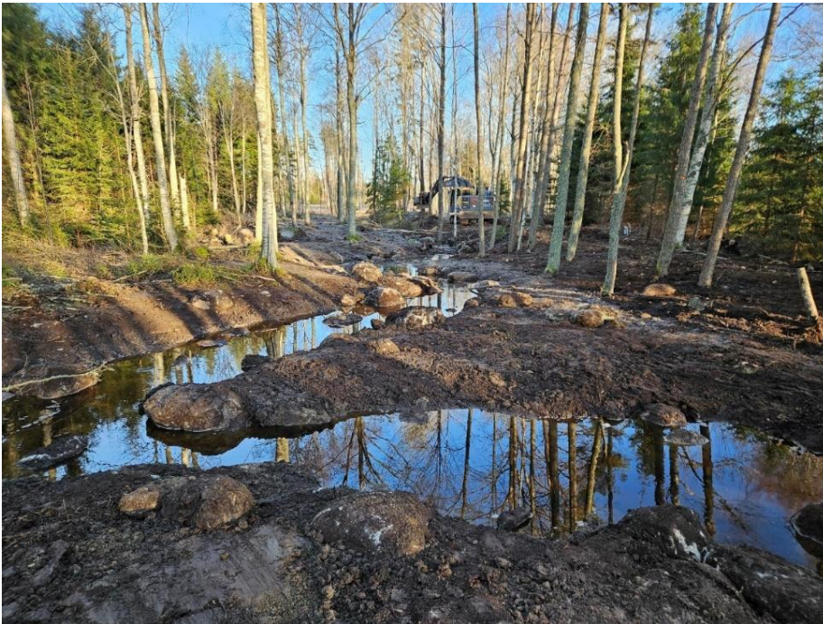
Figur 9. Sista delen av Brostugubäcken som återmeandrats under hösten 2025, därmed är detta LOVA projekt slut. Foto: P. Johansson.
