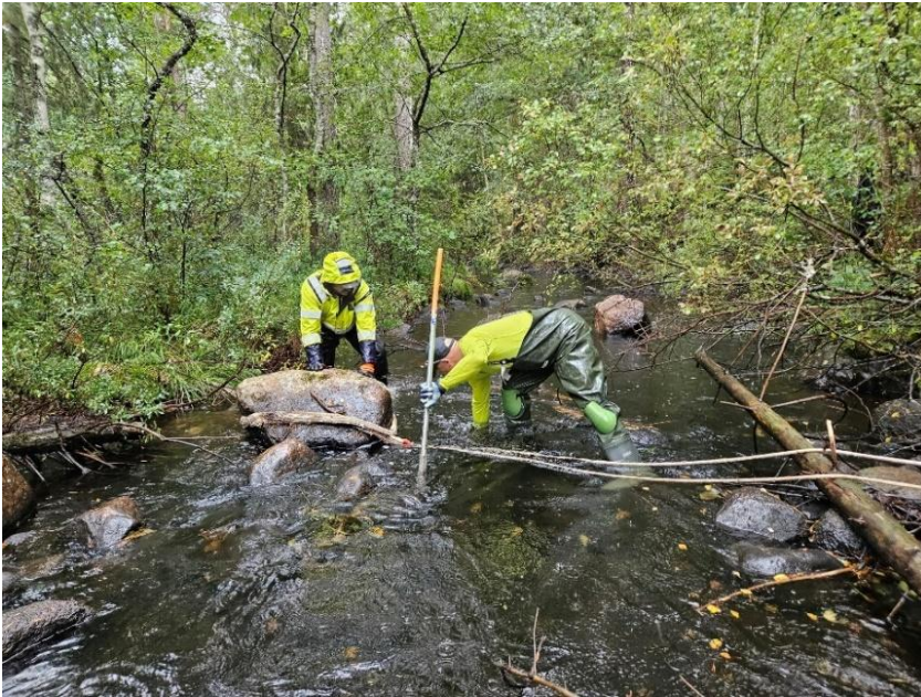
Figur 19. Biotopvård i Silverån där upprensade block vinschas ut i strömmen. Foto: P. Johansson.
