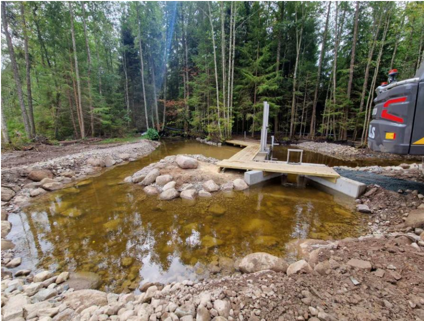
Figur 15. Bild på den nya regleringsdammen med fiskväg vid Storesjöns utlopp. Foto: P. Johansson.
